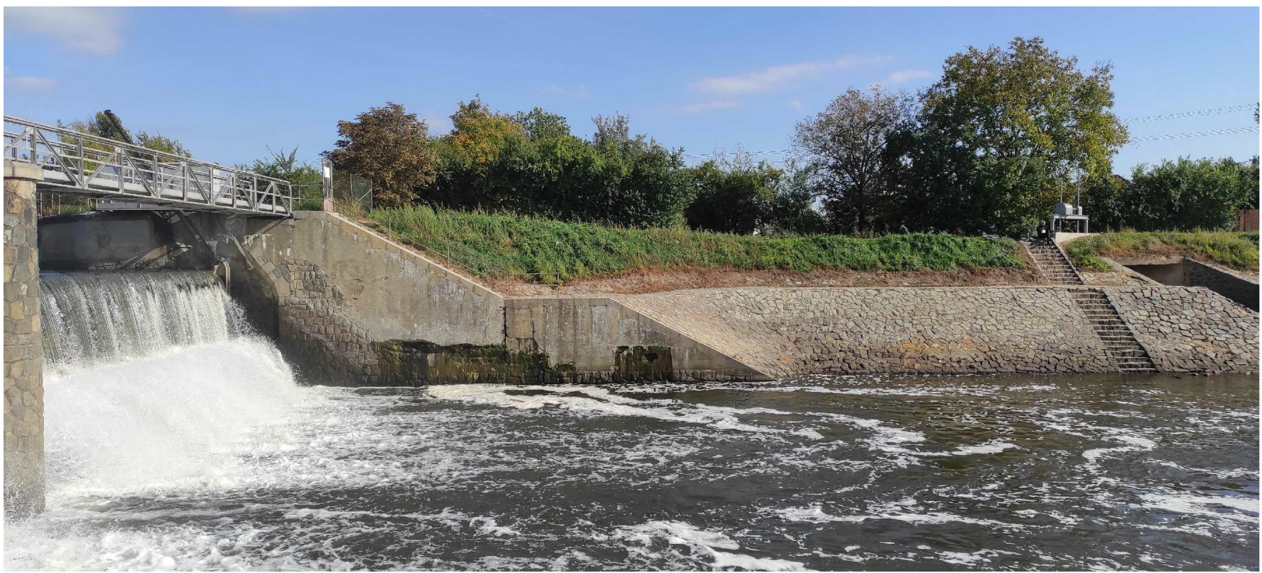
Obr.: Levý břeh pod jezem Rajhrad - stav dlažeb v říjnu 2022
