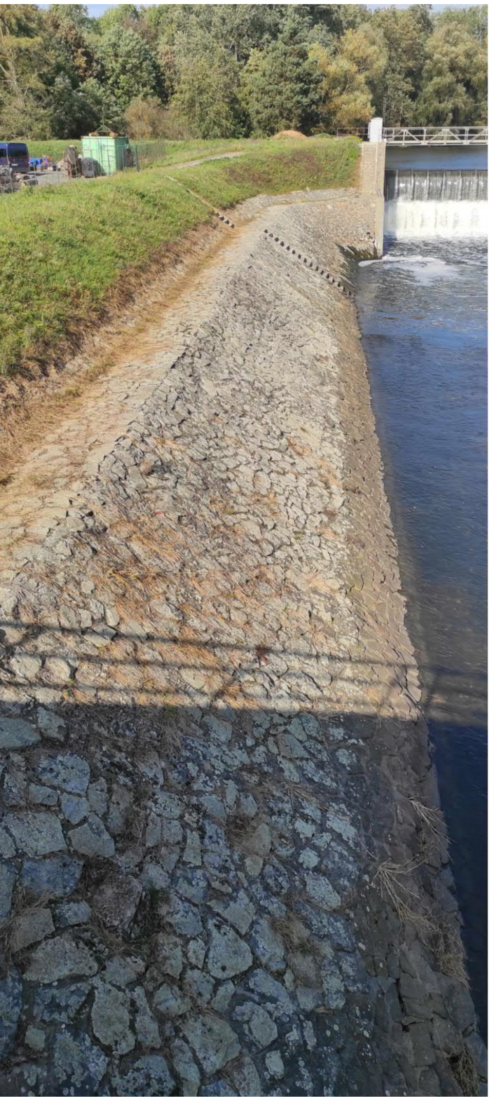
Obr.: Pravý břeh pod jezem Rajhrad - stav dlažeb v říjnu 2022
