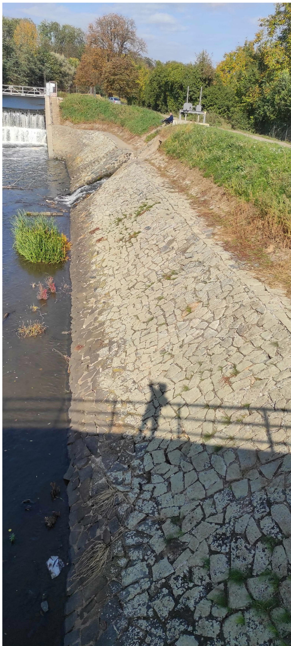
Obr.: Levý břeh pod jezem Rajhrad - stav dlažeb v říjnu 2022
