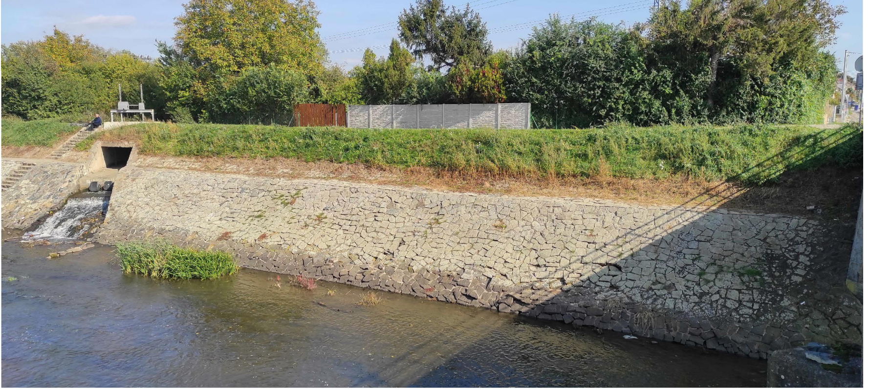
Obr.: Levý břeh pod jezem Rajhrad - stav dlažeb v říjnu 2022
