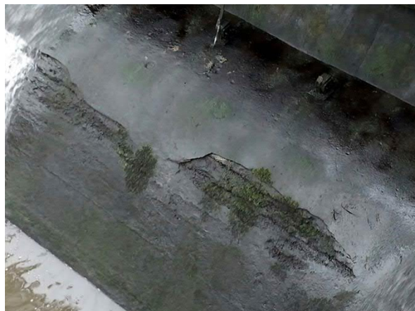
Obr.: Vzhledem ke stavu betonů přelivu se provede celoplošná sanace nahrazením novým betonem.
