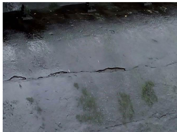
Obr.: Uprostřed pohled na levé pole, dole stav betonů na pravém poli na bubnu přelivné plochy.
