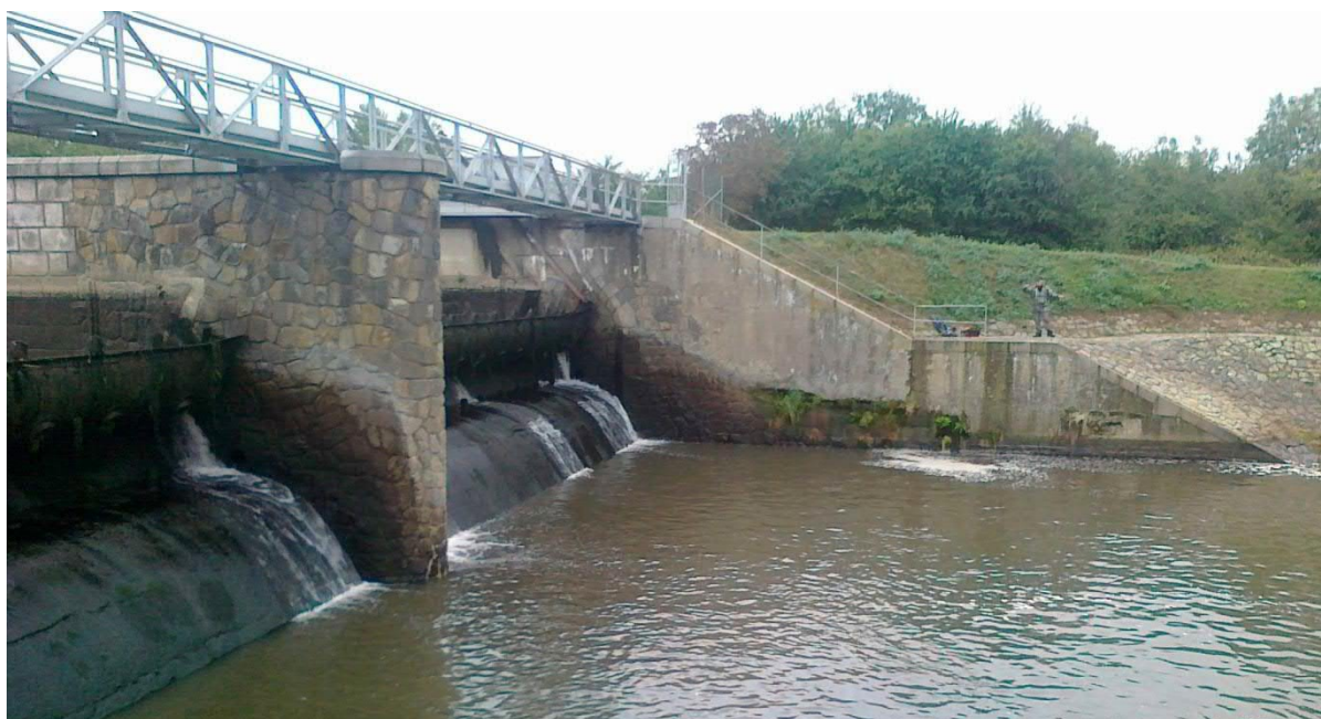
Obr.: V rámci rekonstrukce se provede přespárování (příp. zainjektování) trhlin a kaveren na spodním pilíři a pro zamezení bočních průsaků bude navržena podzemní těsnicí stěna ze sloupů injektáže.
