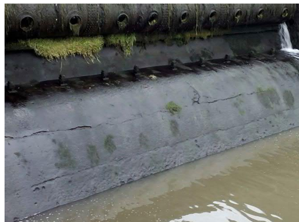
Obr.: Uprostřed pohled na levé pole, dole stav betonů na pravém poli na bubnu přelivné plochy.
