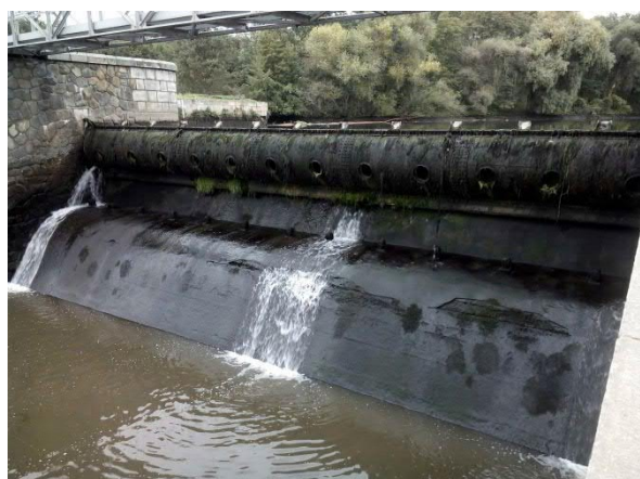
Obr.: Vzhledem ke stavu betonů přelivu se provede celoplošná sanace nahrazením novým betonem.
