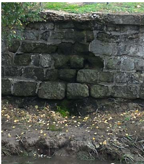
Obr. 3. Významná porucha – zcela vydrolené spáry a degradace staviva
