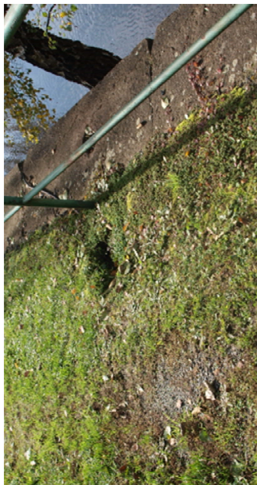
Obr. 2. Místo vznikajícího propadu za rubem zdi
