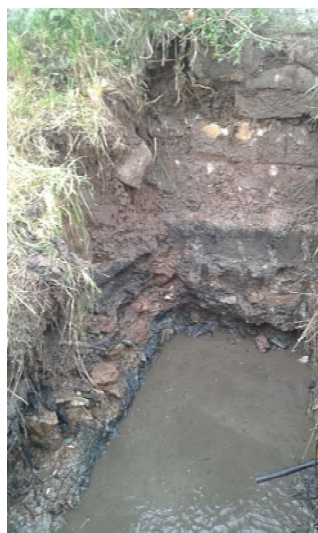
Obr. 5. Výkop provedené kopané sondy a obnažený základ opěrné zdi
