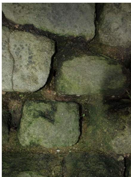
Obr. 18. Zcela vydrolená malta ze spár mezi bloky a probíhající degradace staviva
