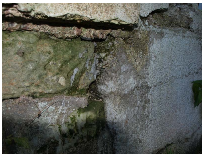
Obr. 7. Pohled na napojení v místě přibetonování opěrné zdi
