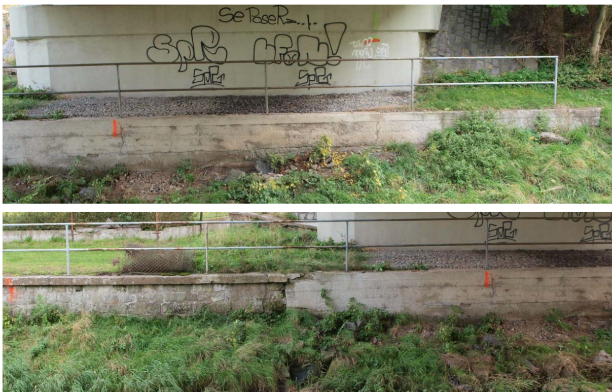
Obr. 8. Pohled na část opěrné zdi pod mostní opěrou sanované přibetonováním
