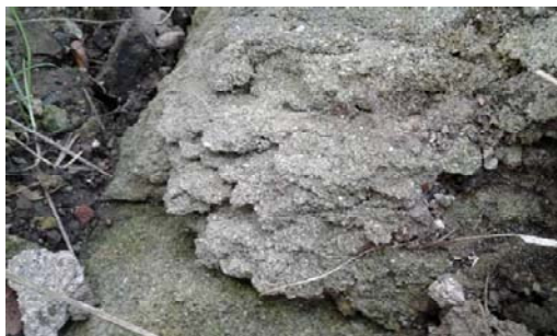
Obr. 14. Úplný rozpad struktury bloku pískovce
