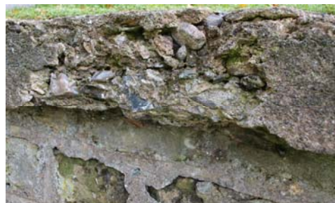
Obr. 17. Rozpadající se římsa – degradace betonu
