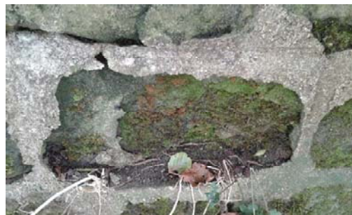
Obr. 15. Mrazový opad a biologická koroze
