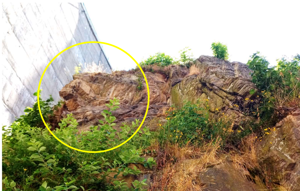
Pohled na partii skalní stěny určenou k zajištění kotvenou lanovou ocelovou sítí s tahovou pevností min. 240 kN.
