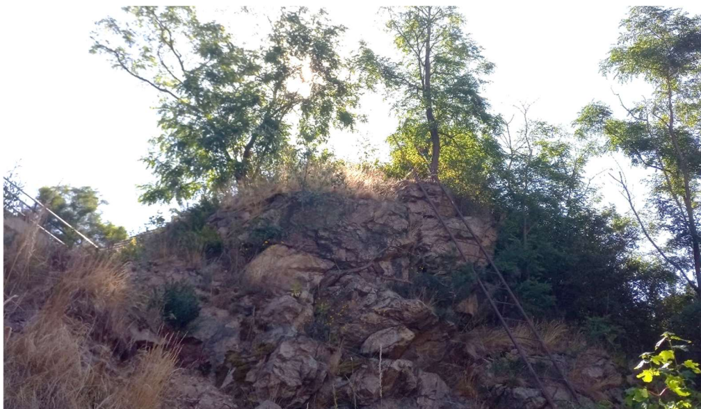
Výrazně rozvolněný a blokovitě rozpadavý skalní výchoz nad pilířem stabilizace. Výchoz je zdrojem nestabilních horninových bloků velkého objemu. Sanačním opatřením je navržena záchytná konstrukce dynamické bariéry energetické třídy 1000 kJ.
