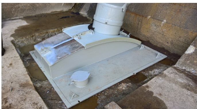
Foto č.3 – Skříň hydromotoru
