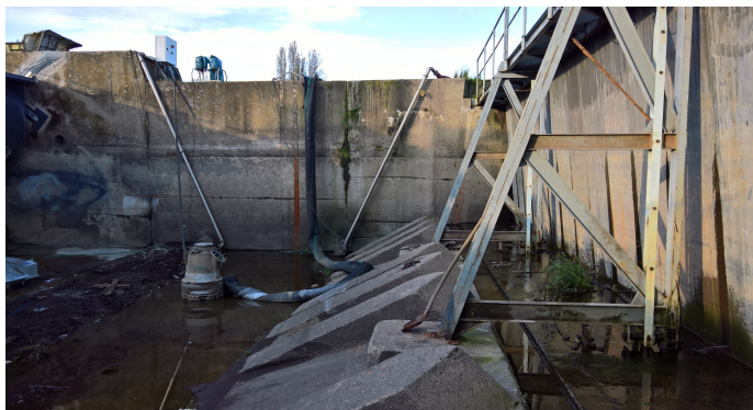
Foto č.1 – Slupice a hradící systém
