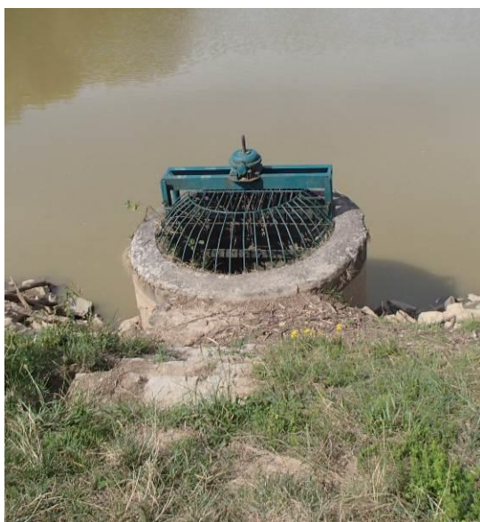
Obr. č. 9, 10 Pohled na šachtu požeráku, pohled na odpadní koryto od spodní výpusti (pohled po vodě) dne 7.8.2024
