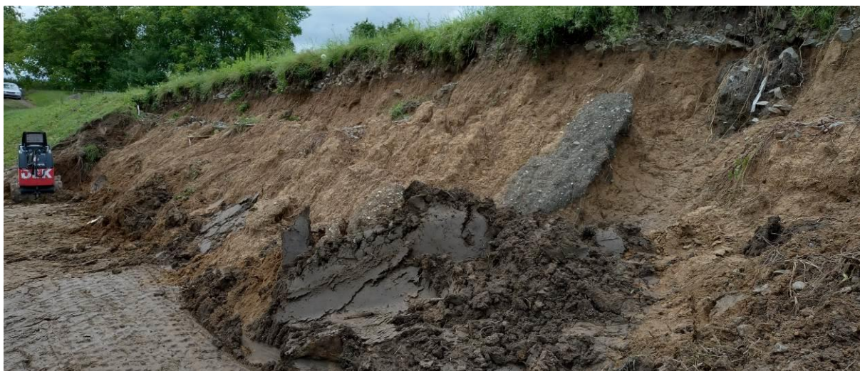
Obr. č. 4 Nátrže vzdušního svahu hráze po povodni dne 4.7.2024
