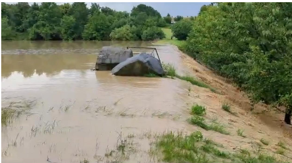
Obr. č. 1 Přelití koruny hráze při povodni 27.6.2024, snímek z videozáznamu
