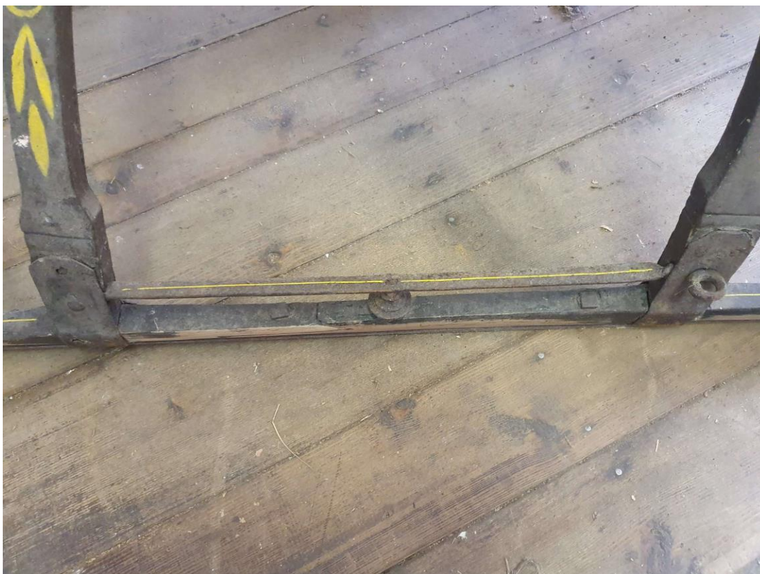
Obr.č.13. Na snímku střední část skluznice s nášlapy pasířské řešení připevnění skluznice k podnoží.saní
