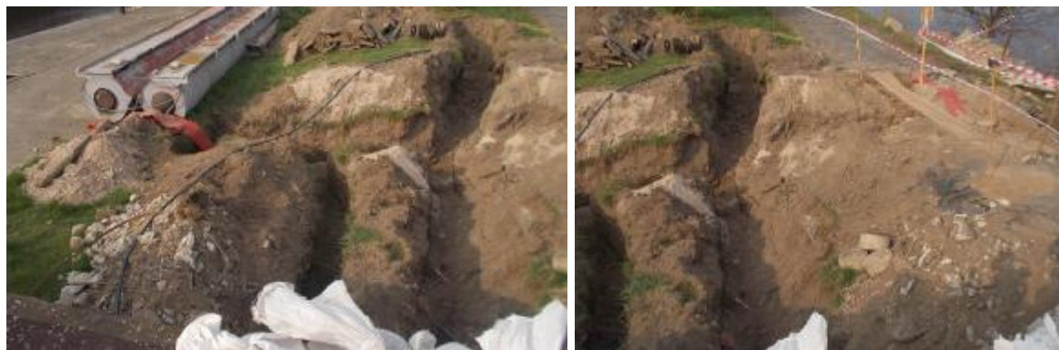
Výkopy pro IS v hrázi pod skladem hradidel
