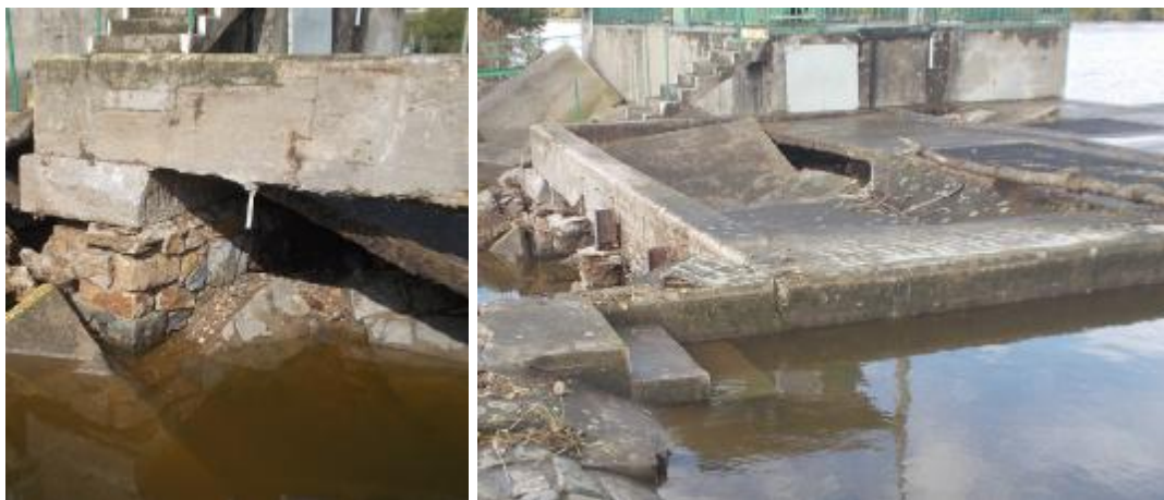
Betonový trám k podepření a prolámané vrchní desky pilíře
