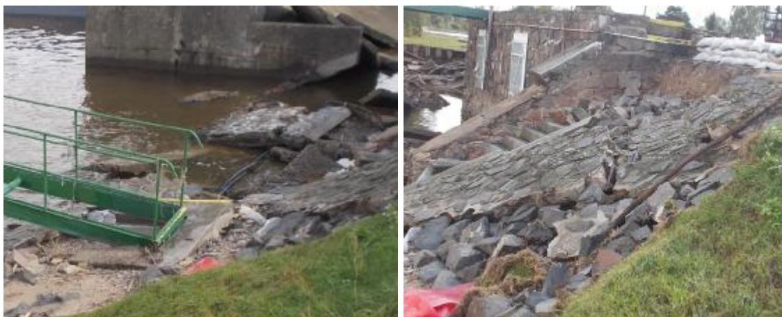
Obrázky poškození levého břehu pod LB pilířem jezu
