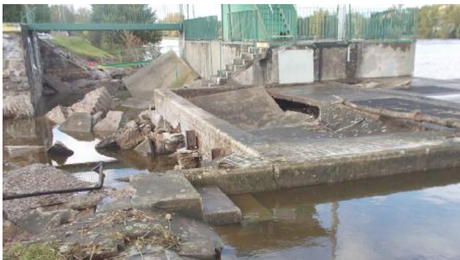
Rozsah poruchy mezi levým pilířem a skladem hradel
