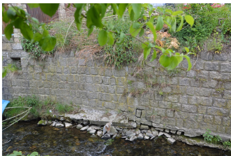
Obnažené základy pravobřežní zdi.
