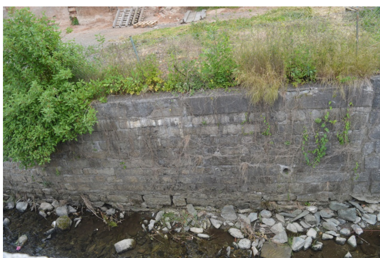
Oplocení levého břehu, kanalizační výúst a poškozená pata zdiva.
