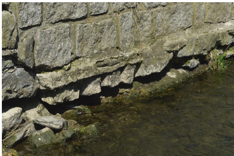
Poškozené základy a zahloubené dno při levém břehu.
