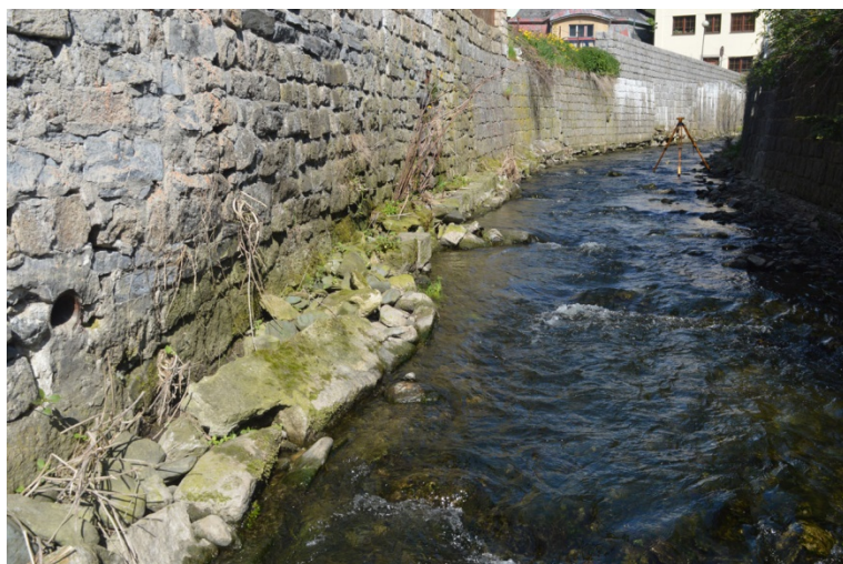
Celkový pohled (proti proudu) do koryta Žernovníku v místě stavby přibližně z dolního konce úpravy. V levé části snímku je patrné poškozené spárování zdiva, je zřejmé i zahloubení dna toku.
