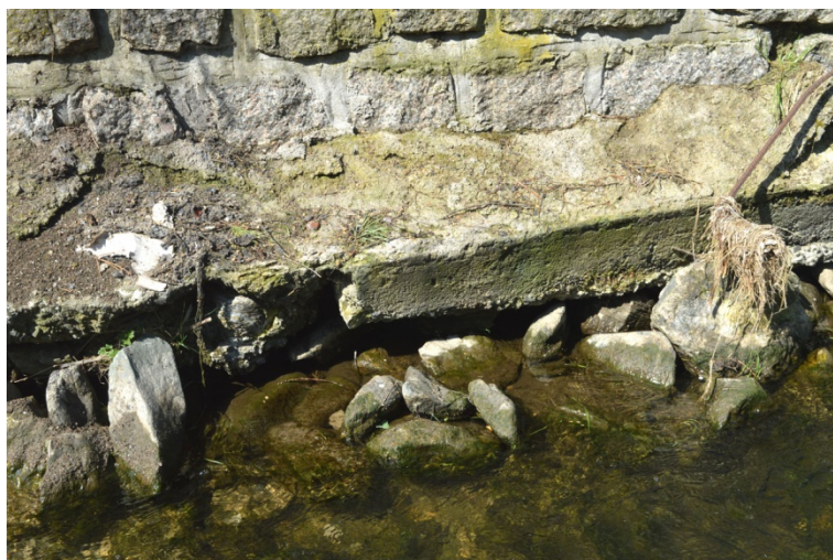
Poškozené sanace a zahloubené dno při pohledu na pravý břeh.
