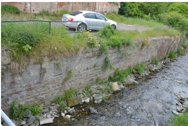
Pohled na levobřežní zeď s poškozenou korunou.
