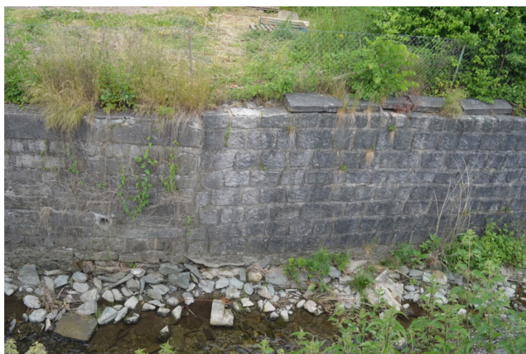
Poškozená koruna levobřežní zdi.
