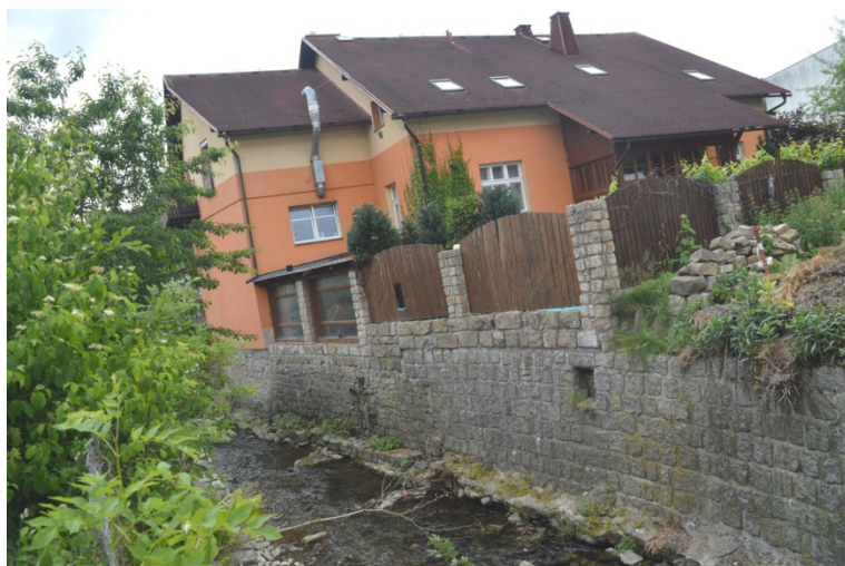
Pohled z levého na pravý břeh směrem po toku. Jsou patrné poškozené starší sanace základů zdiva.
