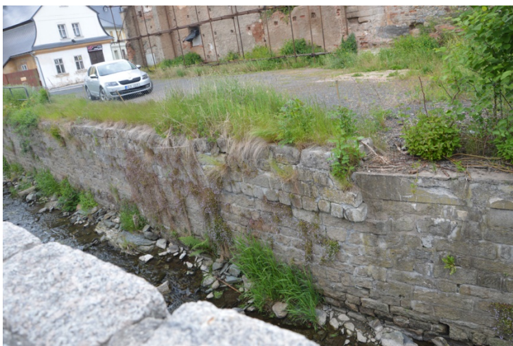
Při pohledu na levý břeh je patrné mírné vyboulení zdiva směrem do toku.
