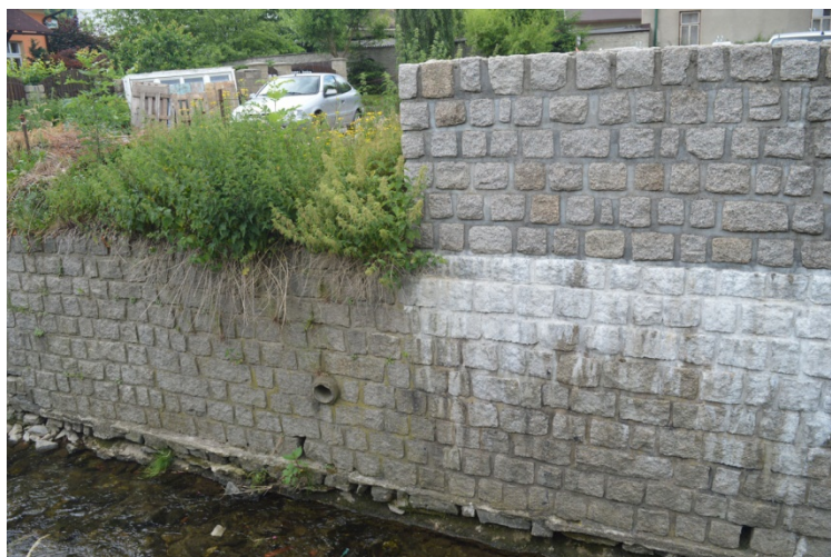
Kanalizační výúst v pravobřežní zdi.
