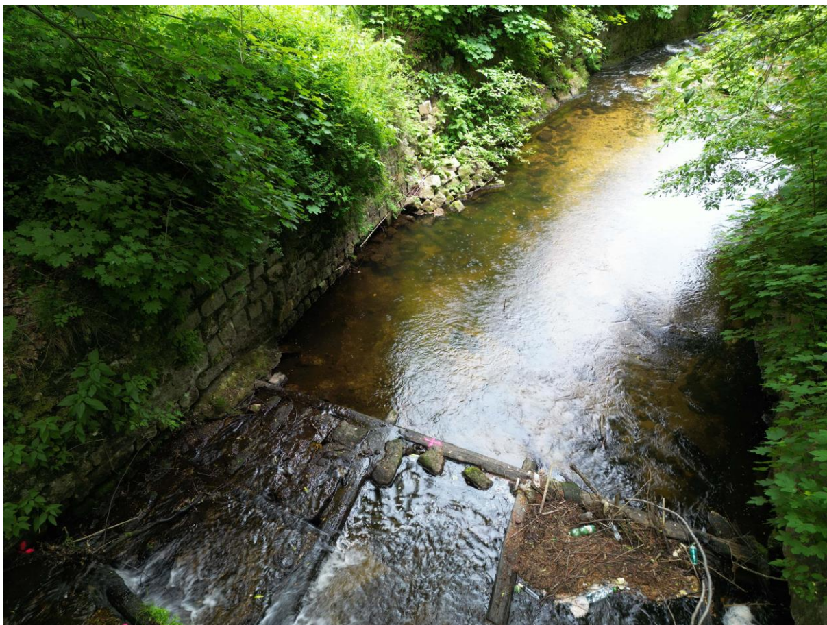
Foto č. 3 – Pohled na levobřežní zeď se zříceným místem pod skluzem
