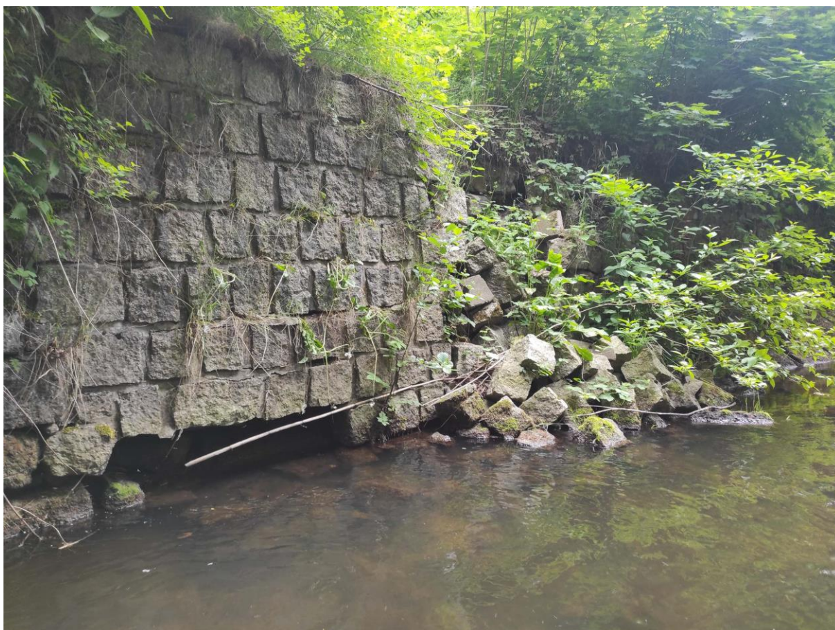
Foto č. 10 – Zřícená zeď na levém břehu pod skluzem
