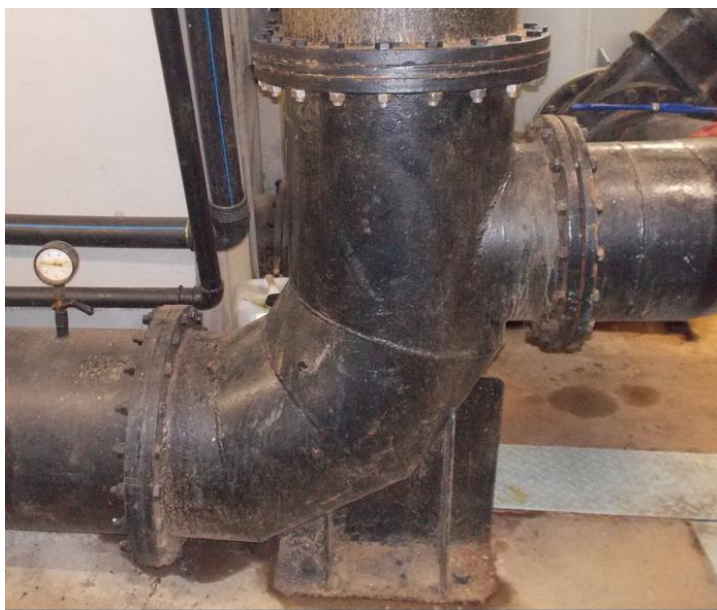
Místo oddělení levého sektoru od potrubního systému – I. Etapa
