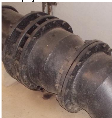
Kompenzátor DN400 na potrubí do DV
