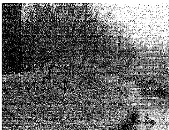
Hráze, kde doporučujeme odstranit náletové porosty a provést jejich stabilizaci
