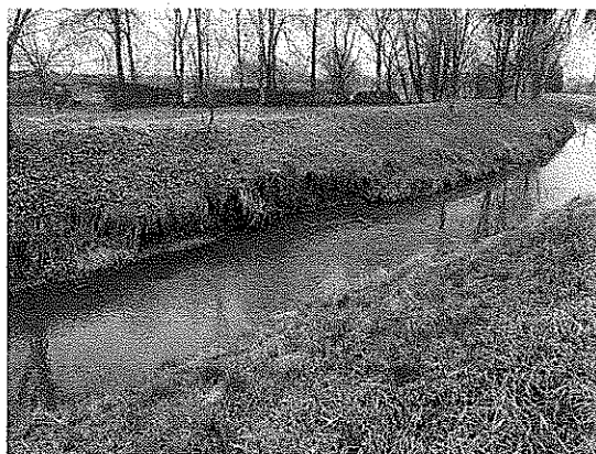
Pohled na hráze z mostu v Bystročicích, směrem k dálnici, poškozená pata svahu
