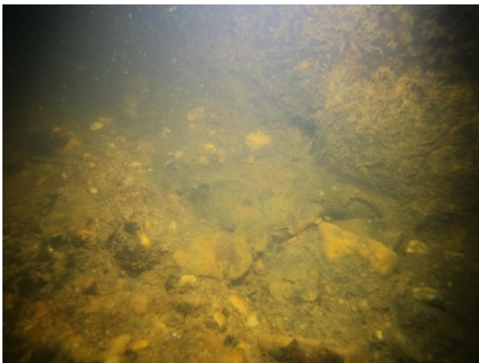
Foto: VD Brandýs n.L. – kaverna ve dně prahu č.12
