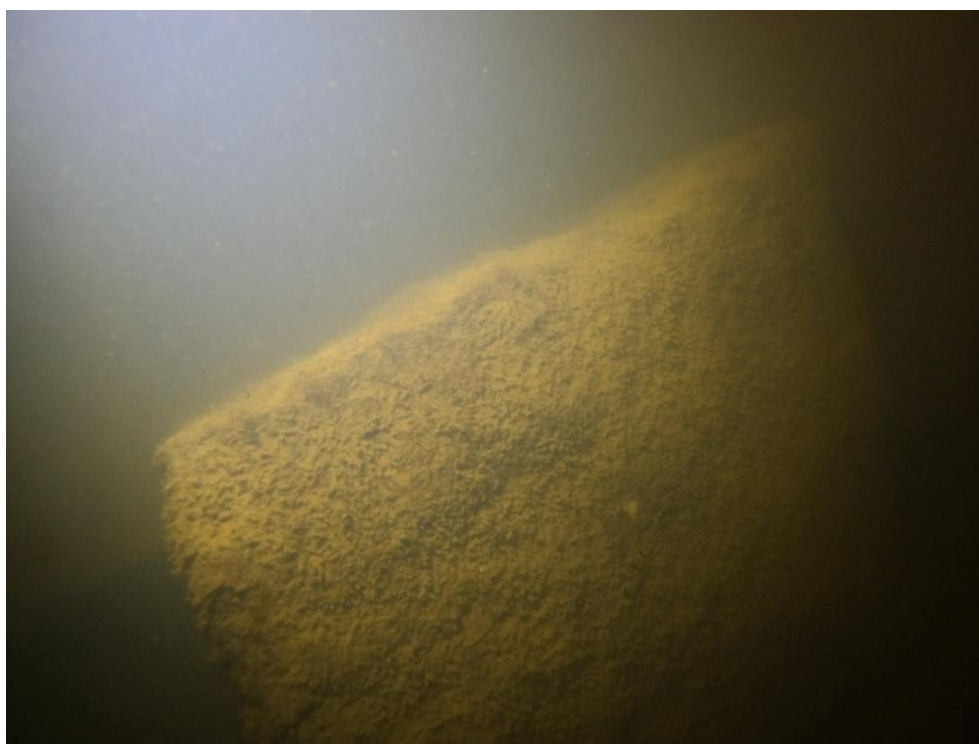
Foto: VD Brandýs n.L. – vystouplé kameny jako rozražeče v podjezí
