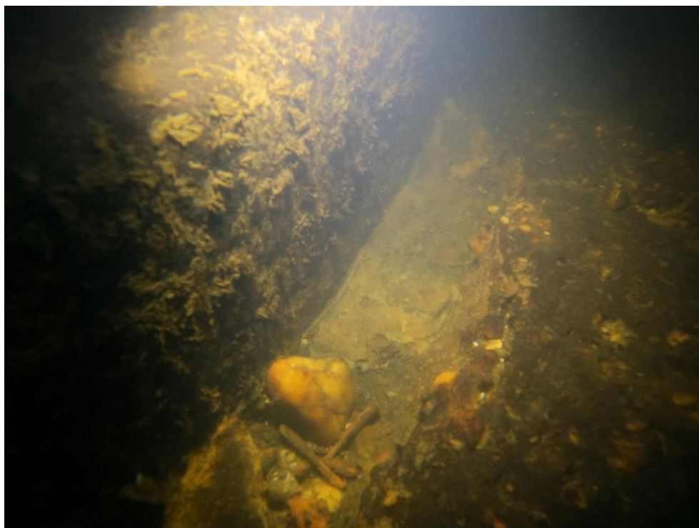
Foto: VD Brandýs n.L. – kaverna ve dně prahu č.8
