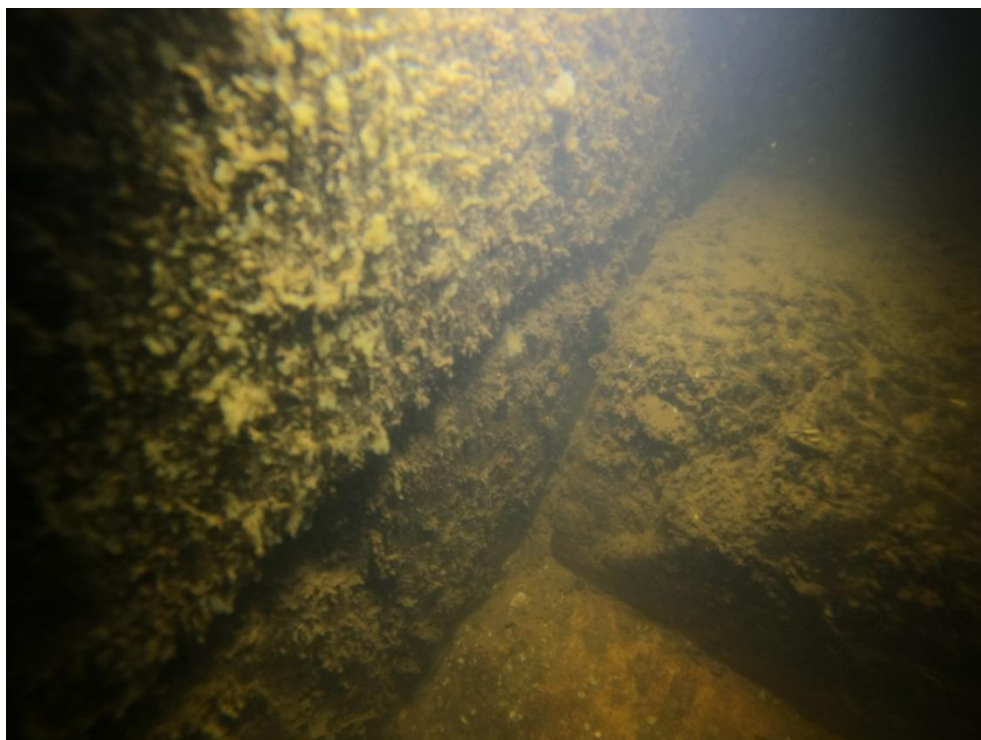
Foto: VD Brandýs n.L. – poškozené spárování u paty pilíře a prahu č.13
