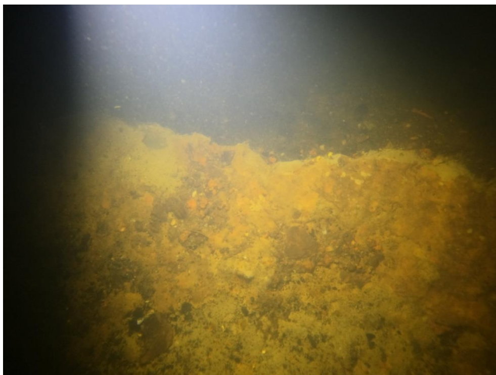
Foto: VD Brandýs n.L. – opravená prasklina v nadjezí levého jez.pole
