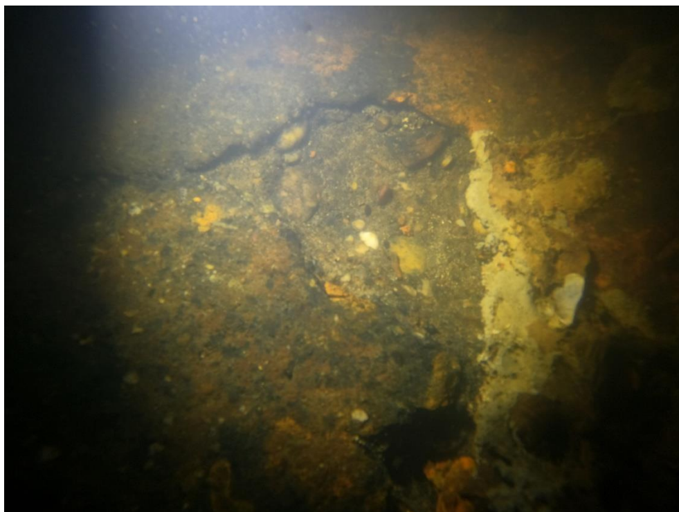
Foto: VD Brandýs n.L. – kaverna ve dně prahu č.6
