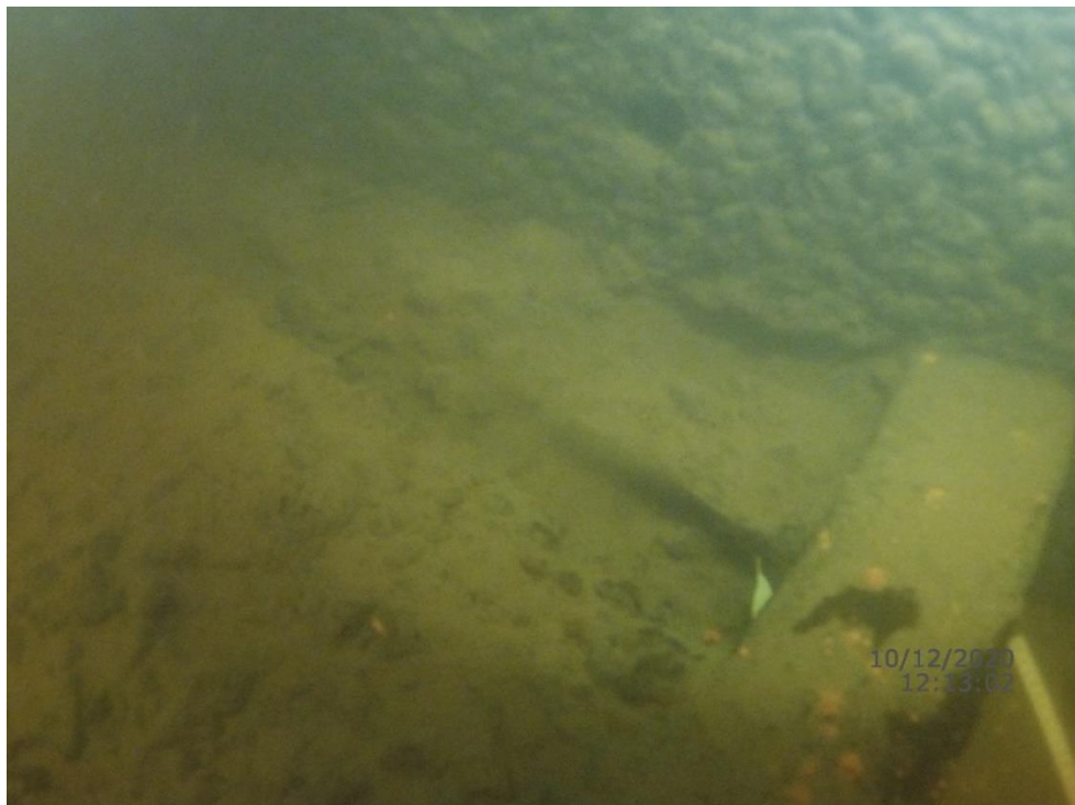
Foto PS a.s. – střední jezové pole – drobná porucha prahu
