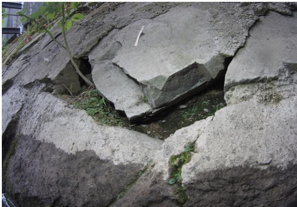
Obr. PS, a.s. MPK dolní ohlaví, poškozené spárování
