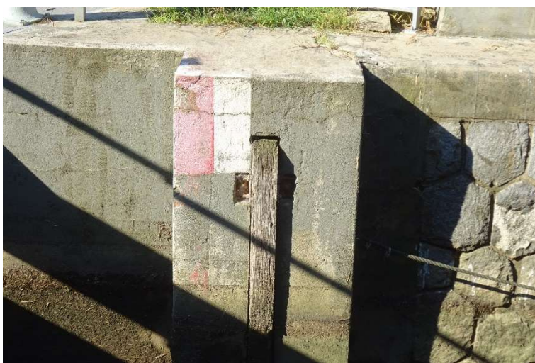
Pohled na odrazný trámec na pravé straně komory v dolním ohlavi – úroveň plata:
