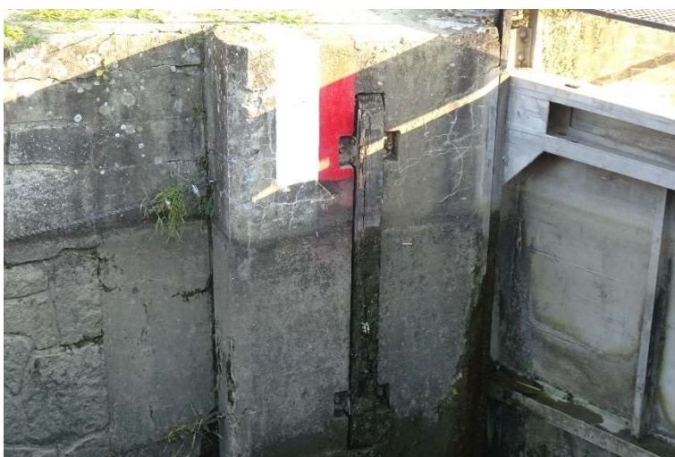
Pohled na odrazný trámec v pravém vrátnovém výklenku horního ohlavi:
