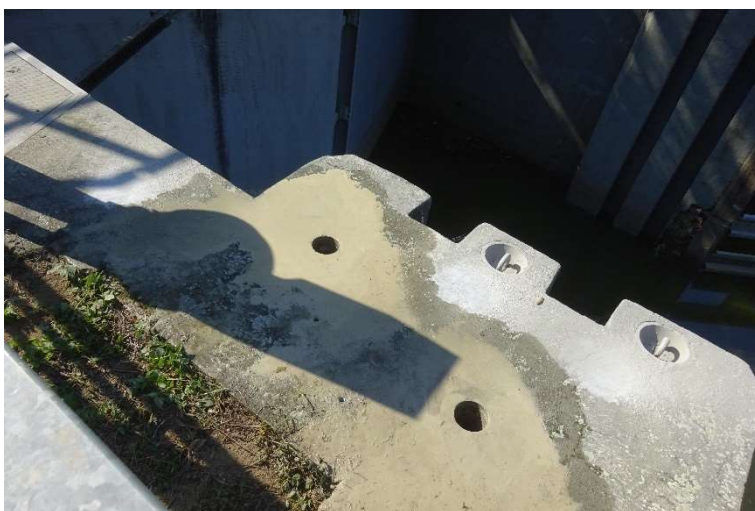
Jádrový vrt NV1 a NV2 v horním ohlavi
