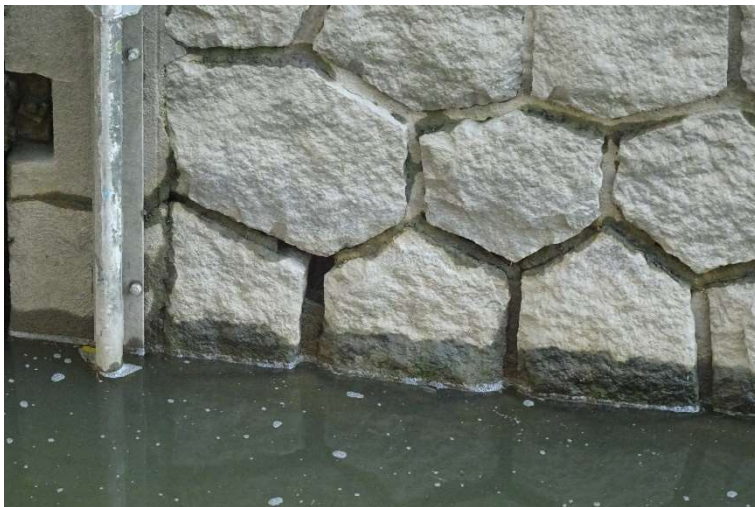
Vyplavené spárování zdiva na levé stěně v užitém prostoru.
