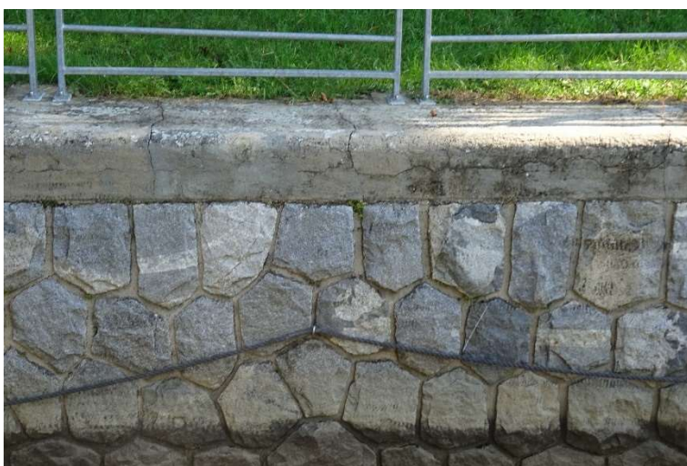
Síť trhlin na levé stěně v úrovni pláta.
