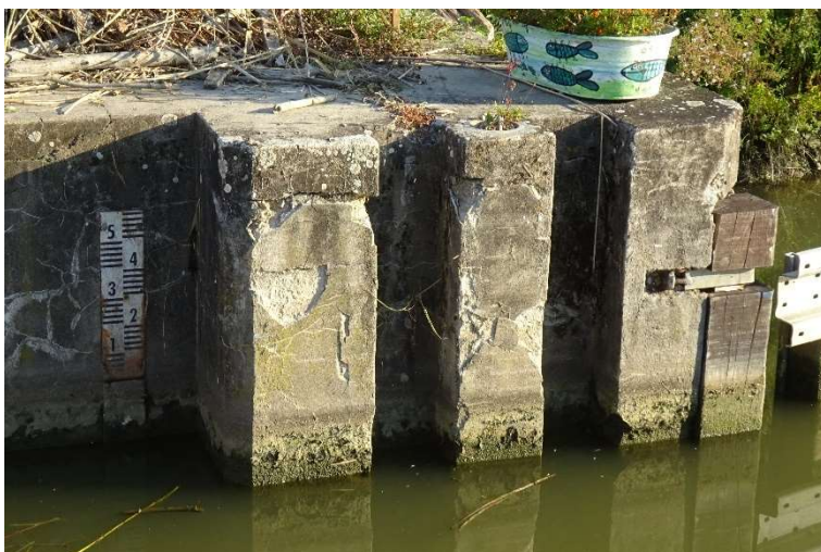
Betonová žebra na pravém vrátňovém výklenku horního ohlaví:
