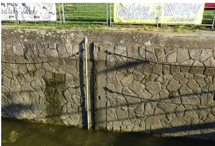
Pohled na odrazný trámec na pravé straně komory ve 3/3 délky:
