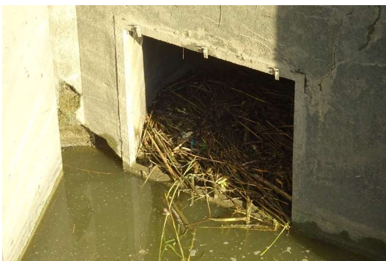
Vtokové okno na pravé stěně ve vrátnovém výklenku:
