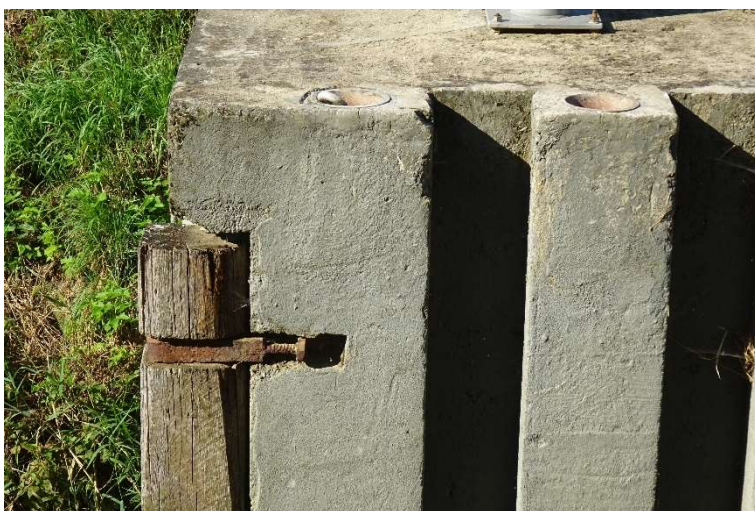
Detail horního připevnění pravého odrazného trámce před dolním ohlaví:
