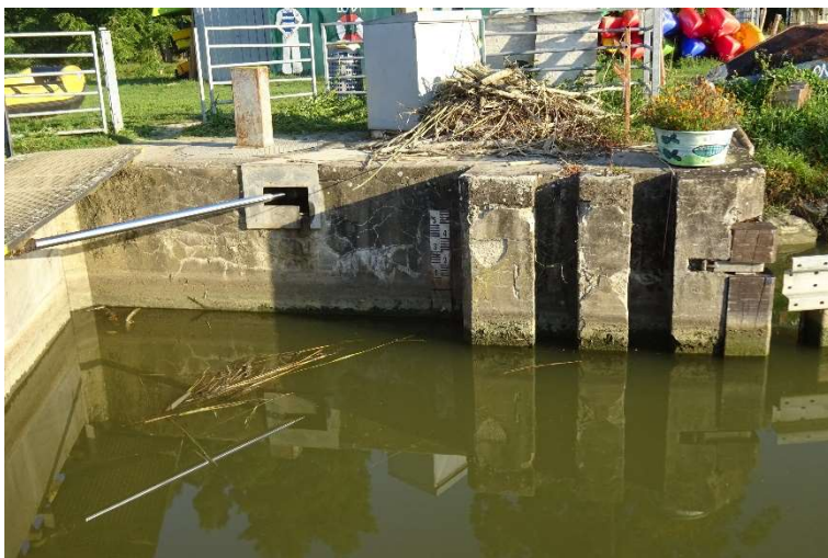
Pohled na pravý vrátňový výklenek horního ohlaví:
