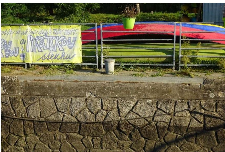
Detail vodorovného pancéřování plata pravé stěny v užitém prostoru v 3/3 délky:
