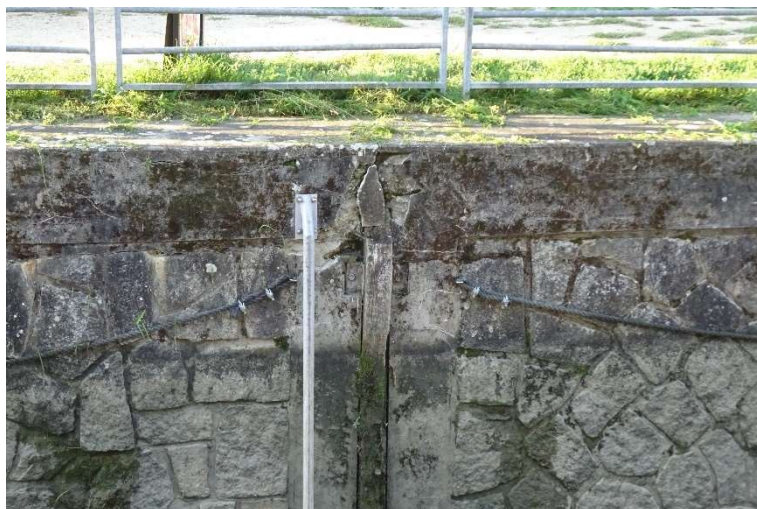
Odrazný trámec na levé straně komory v 2/3 délky – úroveň plata:
