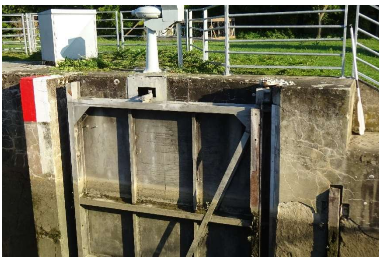
Pravé křídlo protipovodňových vrat v dolním ohlavi – úroveň plata:
