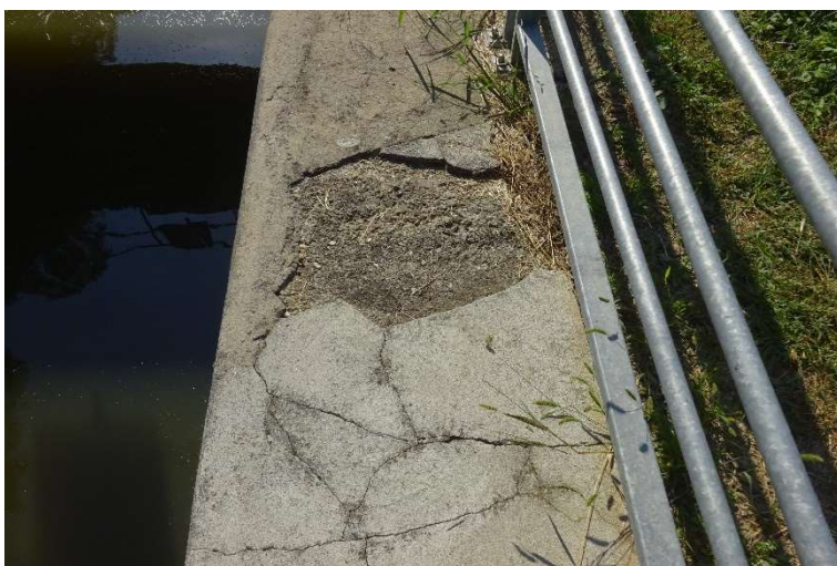
Rozpad betonu na horním povrchu pravé stěny se sítovými trhlinami.
