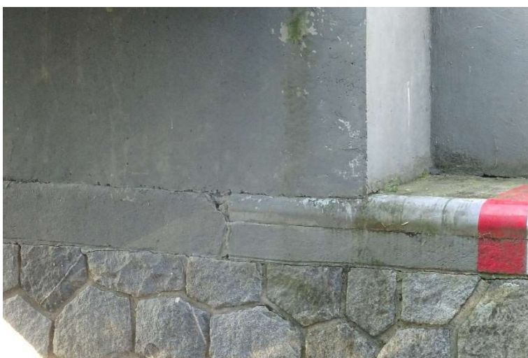
Napojení vodorovného pancéřování hrany na OP2:
