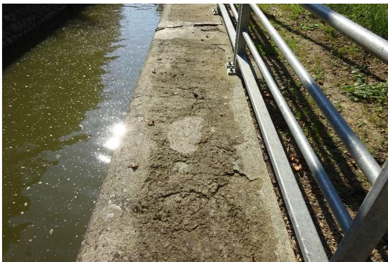
Degradace betonu na horním povrchu pravé stěny.
