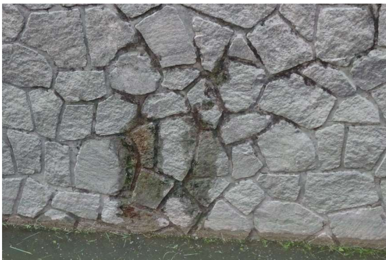
Průsaky ve spárování zdiva na levé stěně plavební komory.
