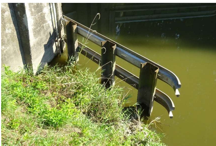
Ocelové svodidlo na levé straně dolního ohlaví:
