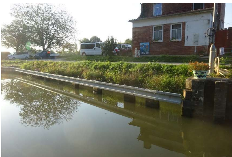
Pohled na levé svodidlo v horní rejdě
