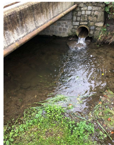
Chráníčka-M1 návodní líc ve dně odkrytá chráníčka vodovodu (v linii výtoku)
