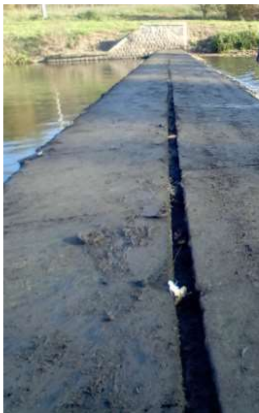
přelivná plocha - pohled
