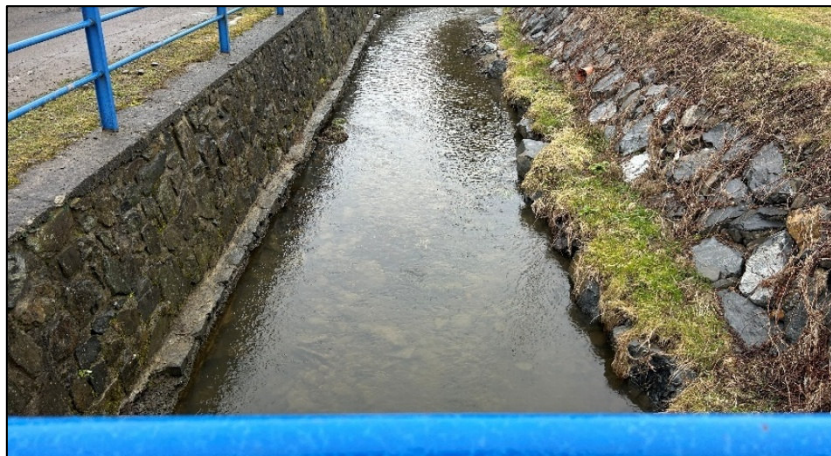
Obrázek 2: Prohloubená niveleta toku v km 5,650 (pohled z mostu v km 5,638 proti proudu)
