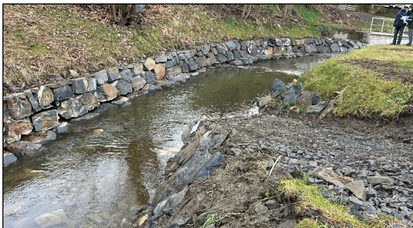
Obrázek 9: Stávající zeď alpského typu v km 5,620 (pohled z pravého břehu po proudu)
