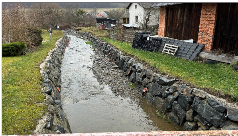
Obrázek 1: Nánosy říčního štěrku v km 4,840 (pohled z mostu v km 4,858 po proudu)
