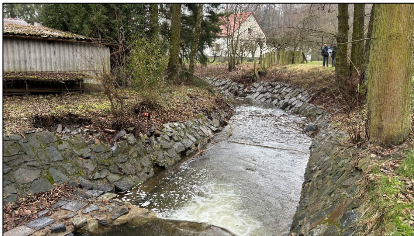
Obrázek 6: Stávající kamenná opevnění v km 6,030 (pohled od kam. stupně v km 6,038 po proudu). Úseky nového opevnění (realizace r. 2023) budou zachovány, případně budou kameny dle potřeby přeskládány.
