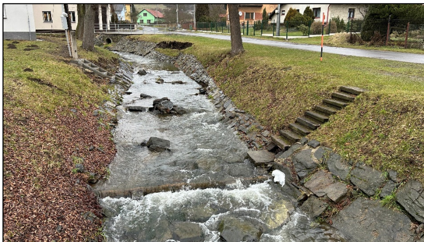
Obrázek 6: Stávající kamenná opevnění v km 6,030 (pohled od kam. stupně v km 6,038 po proudu). Úseky nového opevnění (realizace r. 2023) budou zachovány, případně budou kameny dle potřeby přeskládány.
