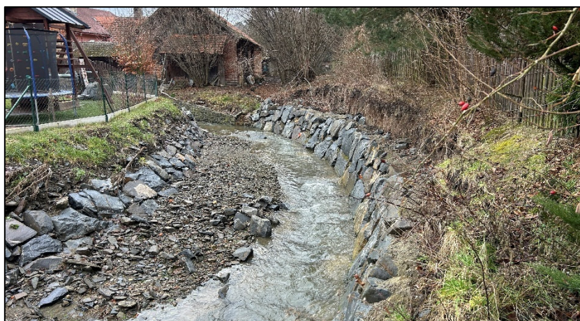
Obrázek 8: Stávající zed' alpského typu v km 4,880 (pohled z mostu v km 4,858 proti proudu)
