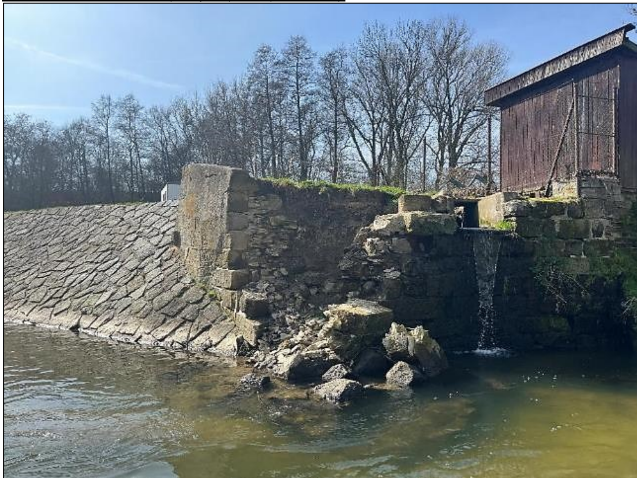
Rozbořená stávající opěrná zeď na levém břehu v podjezí jezové kce v ř. km 8,426 vodního toku Novohradka
