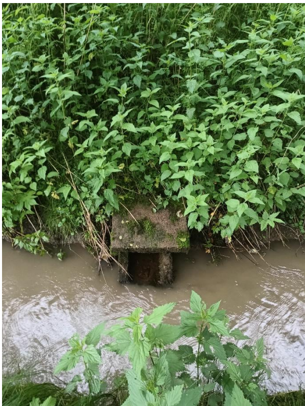
Obr. Vyústění svodného drénu (levá), vyústění příkopu podél lesa nad propustkem (pravá)
