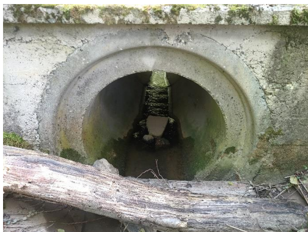
Obr. Propustek pod zájmovým územím DN 1000 (levý), pohled do levobřežního vyústění od šachty.
