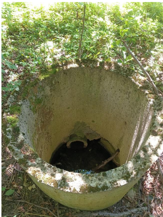
Obr. Skruž před zaústěním do toku na levém a pravém břehu
