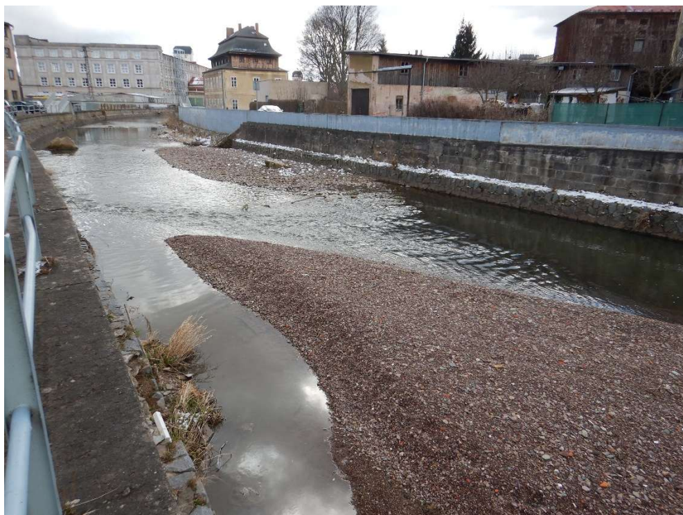
Obrázek 3: Střední úsek – pohled po vodě na nánosy pod mostem ul. Tyršova. (Foto: březen 2025)
