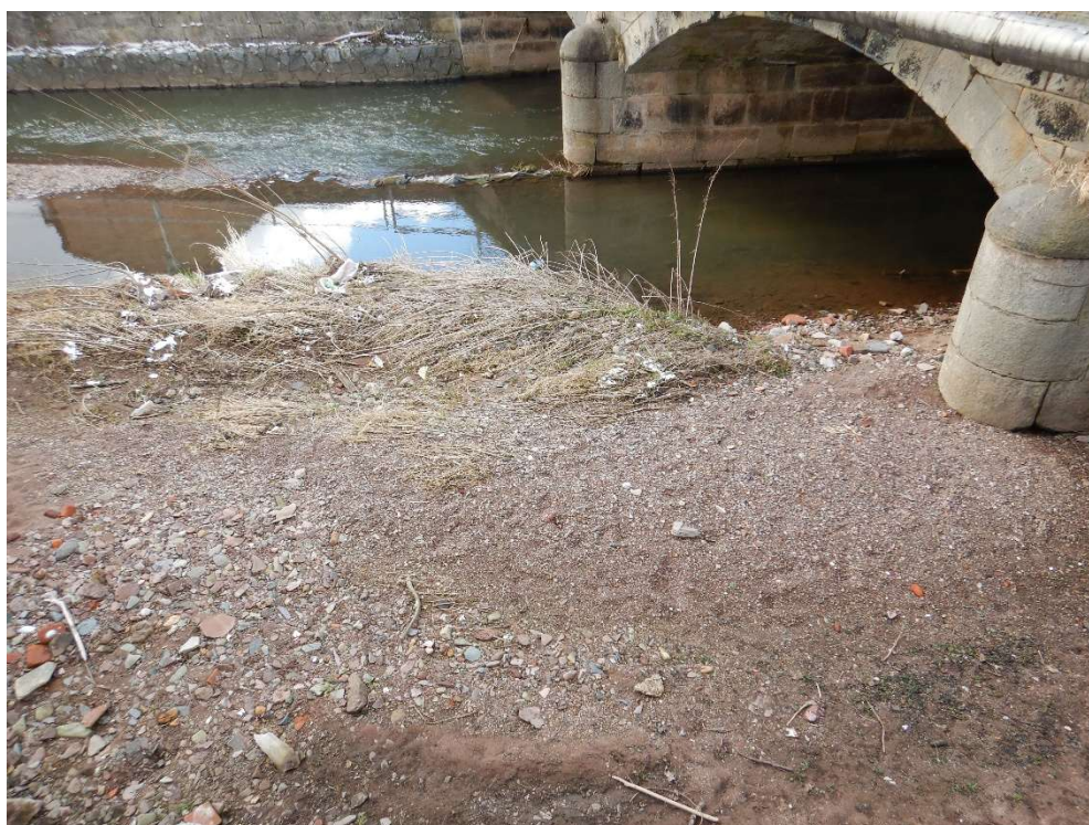
Obrázek 4: Detailní pohled na nánosy pod mostem ul. Tyršova. (Foto: březen 2025)
