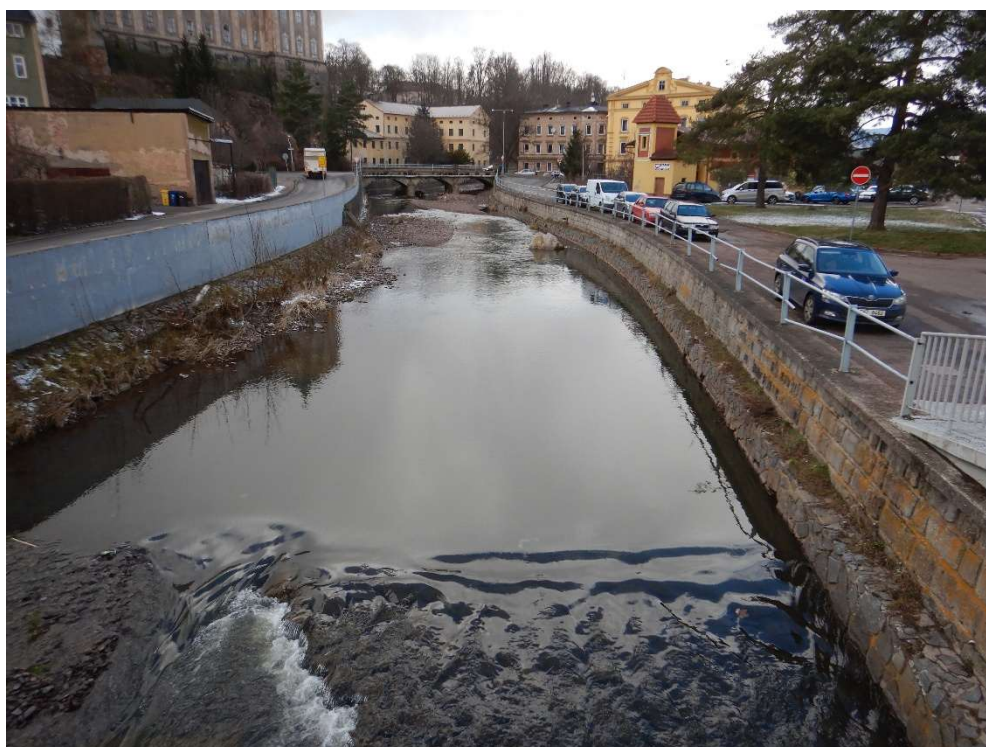
Obrázek 2: Střední úsek - pohled proti vodě na nánosy mezi stupněm ve dně a mostem ul. Tyršova. (Foto: březen 2025)
