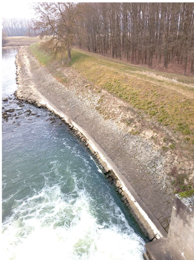
Obr. 1 – pohled na pravý břeh – kompletní odbourání dlažeb
