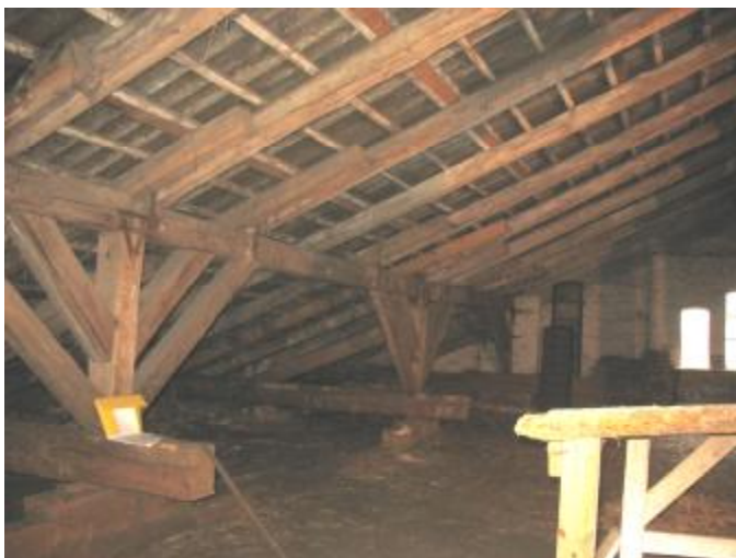
Odřezané vazné trámy, provizorní ocelová táhla a doplněné pásy
