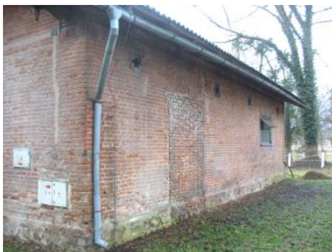
Původní okno, pak vrata, současně zazděno, drážky elektro
