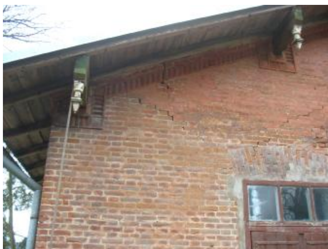
Typické diagonální trhliny ve zdivu
