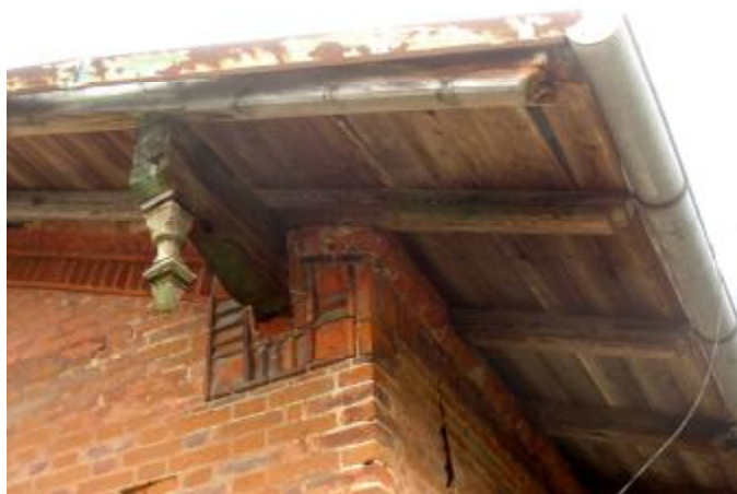
Hnilobou poškozená pozednice a konce krokví
