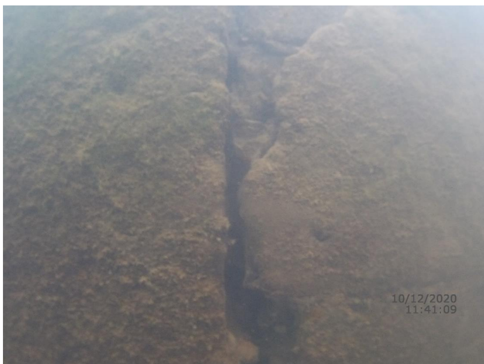
Foto PS a.s. – poškozená svislá dilatační spára na dělicí zdi
