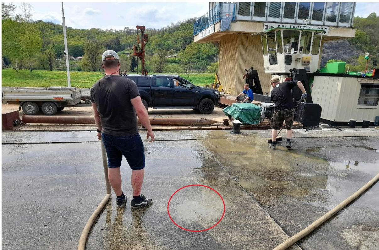
Foto 5 Zapravení vrtu DJ-1 betonovou směsí
