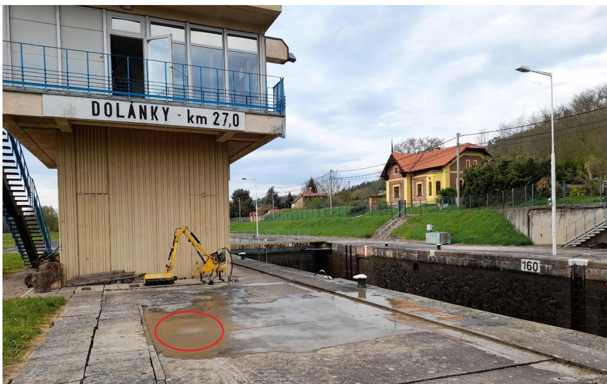
Foto 6 Zapravení vrtu DJ-2 betonovou směsí
