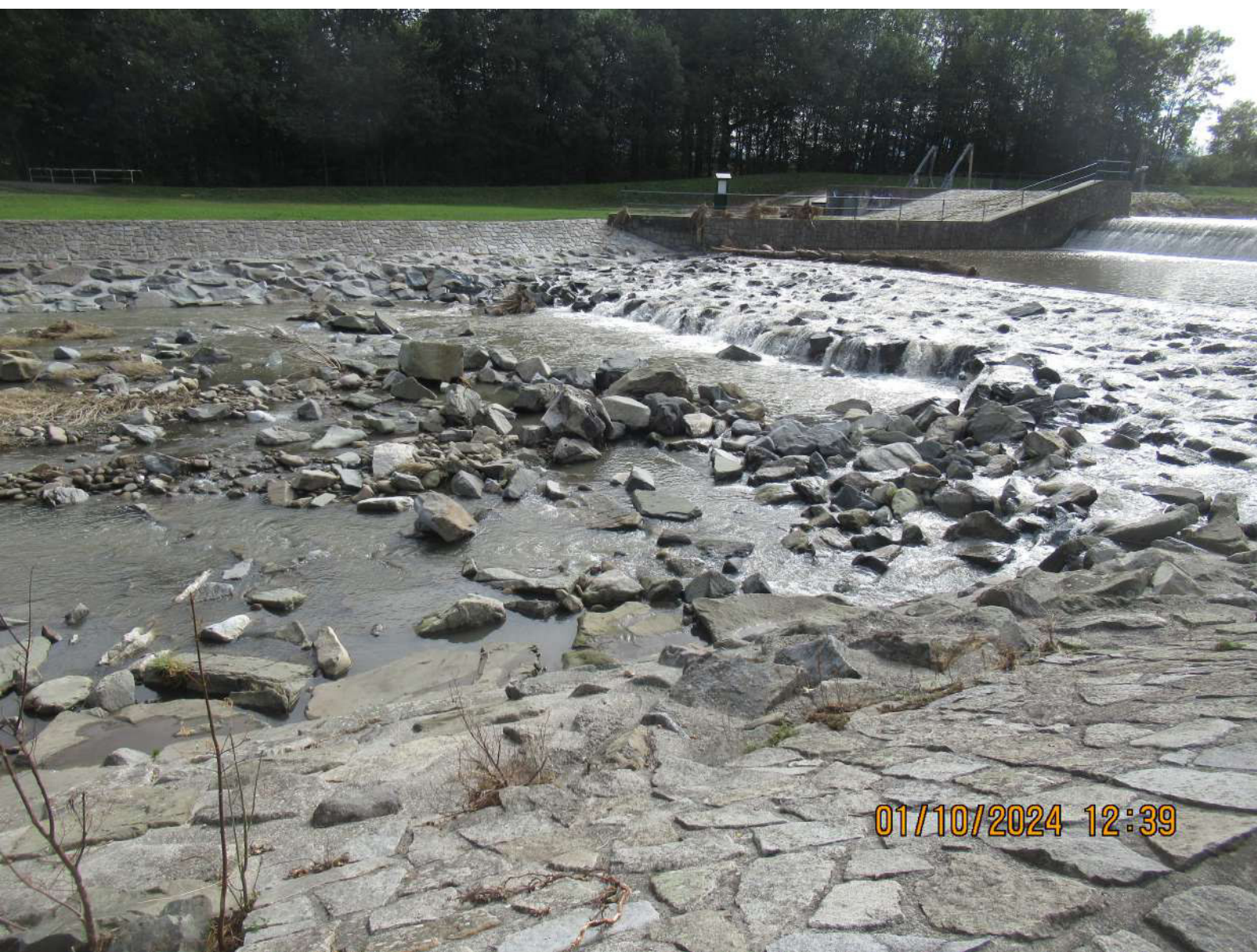
Rozvolněný přechodový prvek jezu - balvanitý skluz
