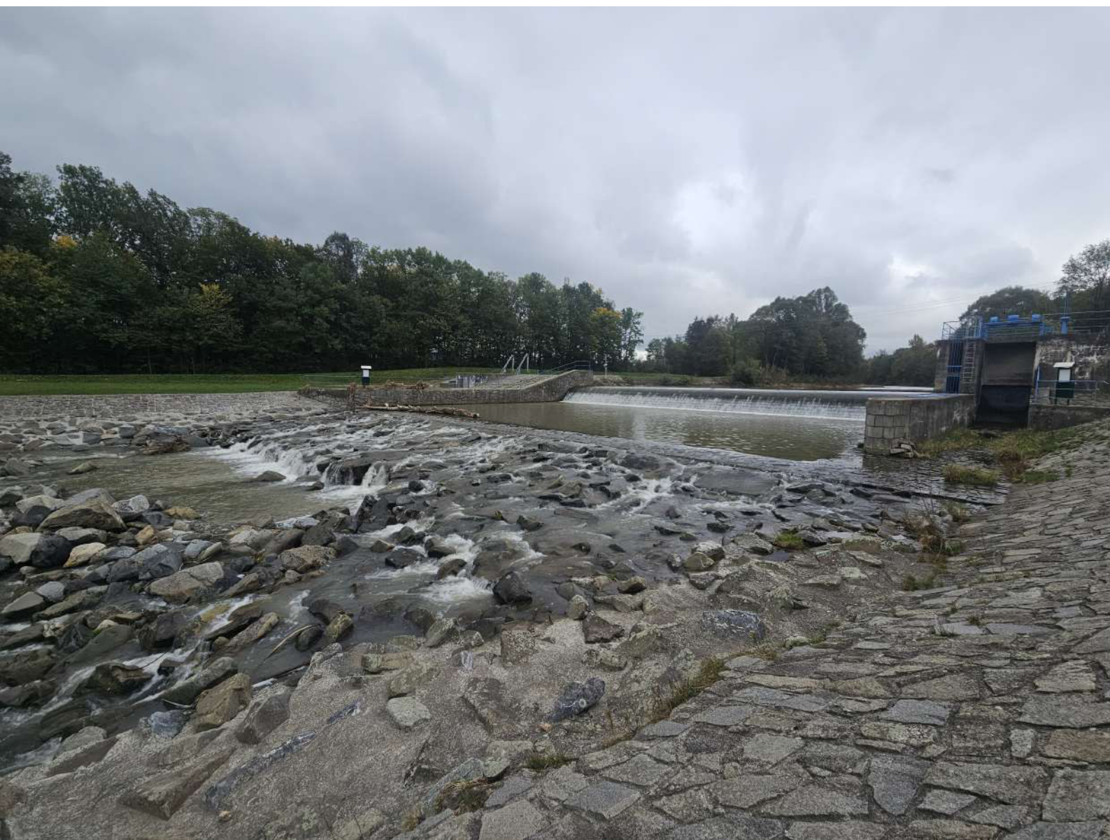
Pohled na jez protivodně z levého břehu
