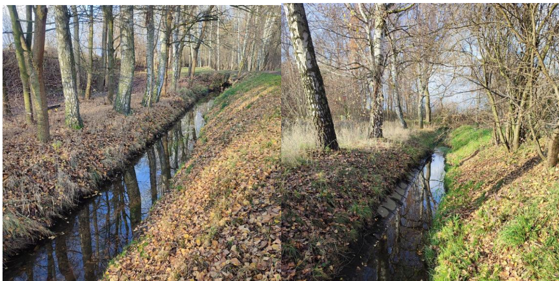
Stouska v Ústíně od začátku úpravy v ř.km 1,4 po 1,850
