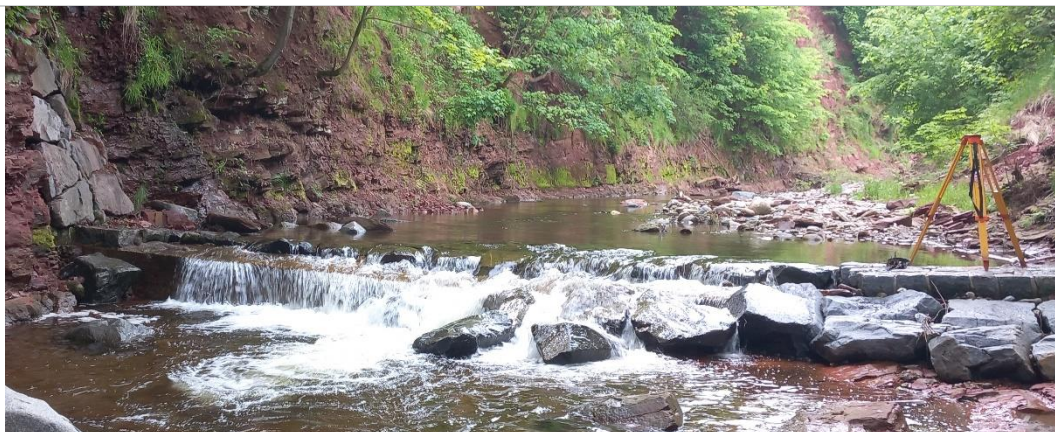
Obr. 10 Pas P1, nejvíce postižený povodní, poškozená koruna prahu (zdivo ze štípaných kopáků), chybějící rovnanina i dno pod
