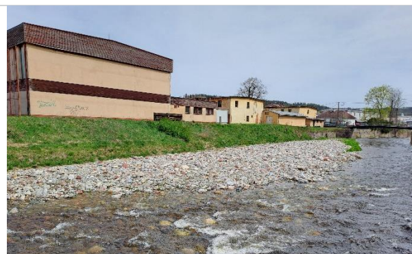
Obr. 18 Spodní úsek – povodňové nánosy nad lávkou, LB
