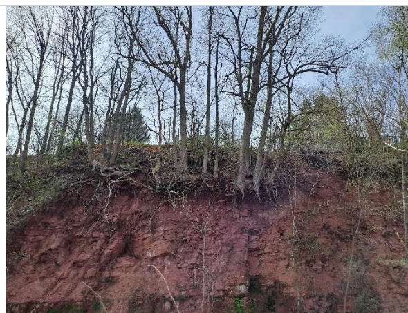
Obr. 14 PB Úpy pod jezem Slezan – vysoké svahy z neúnosných zemin se známkami svahových deformací
