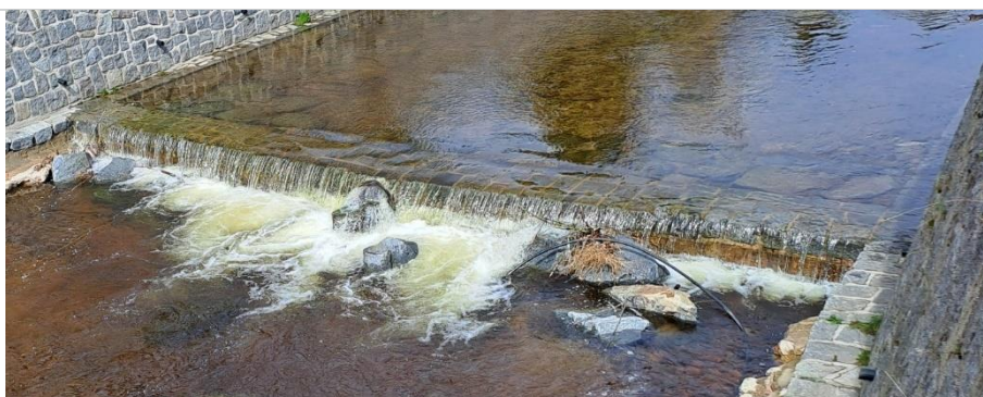
Obr. 6 Pas P3. Při LB zřejmě obnažení ŽB konstrukce pasu, v důsledku silně poškozeného dna (rovnaniny)
