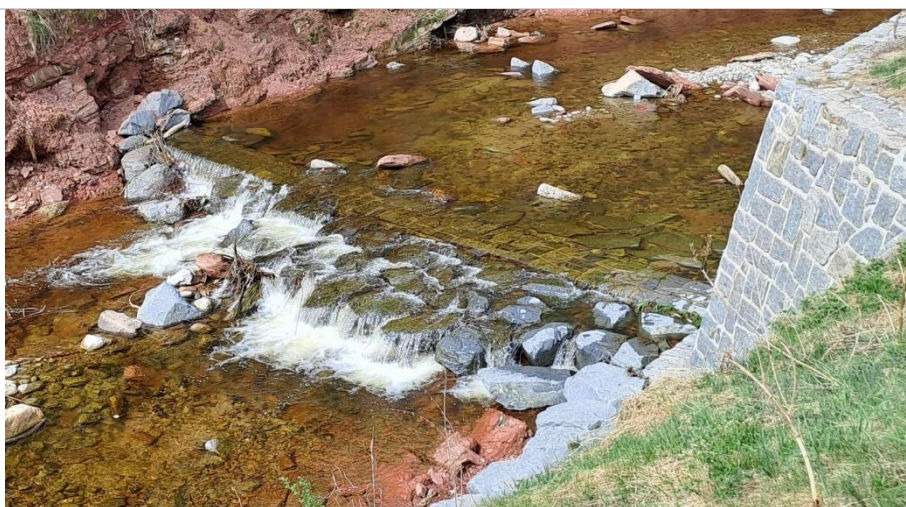
Obr. 8 Pas P2, poškozená rovnanina pod prahem
