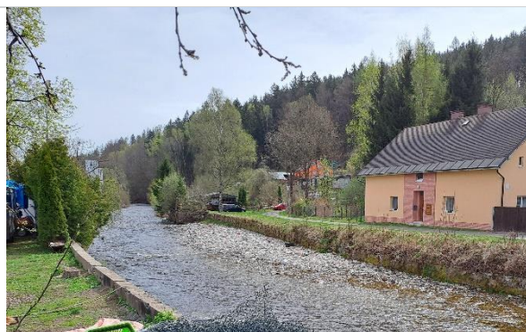
Obr. 19 Spodní úsek – povodňové nánosy při PB pod lávkou
