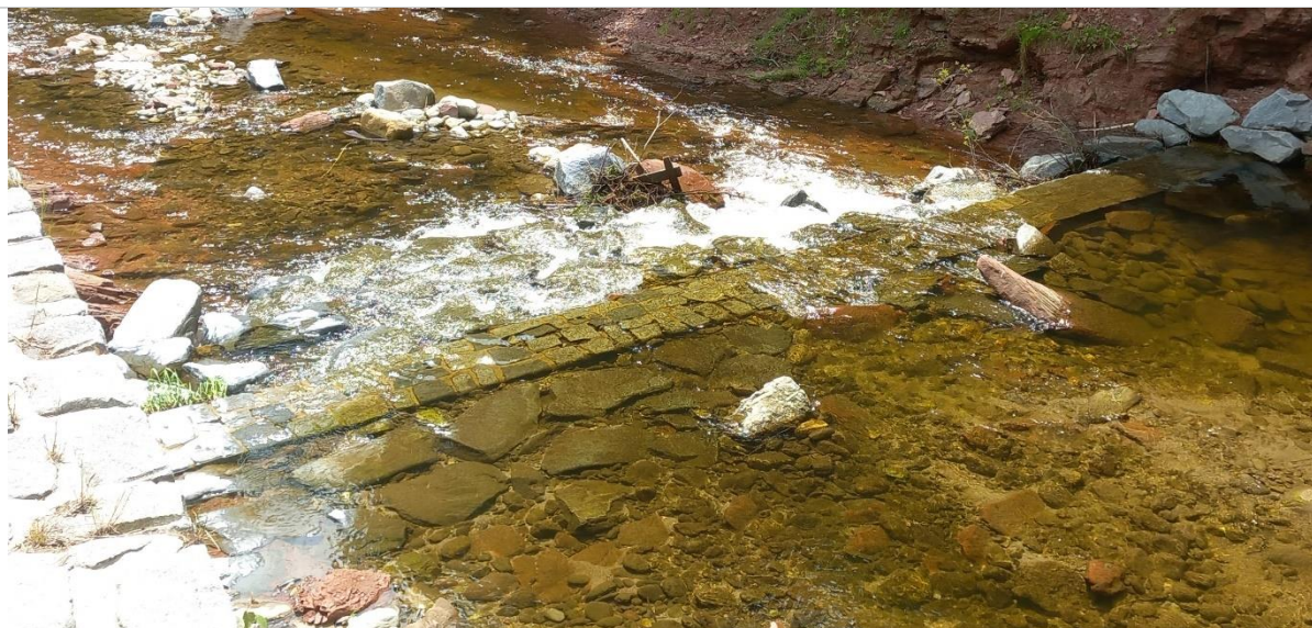
Obr. 9 Pas P2, chybějící rovnanina nad prahem
