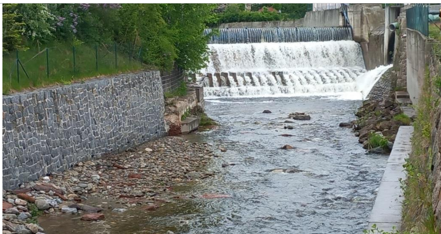
Obr. 4 Jez Slezan, nánosová lavice (dílní zdroj pro opravy-zásypy dna) při PB a vodní hladina skrývá pas P5 (dle zvoleného značení této PD).
