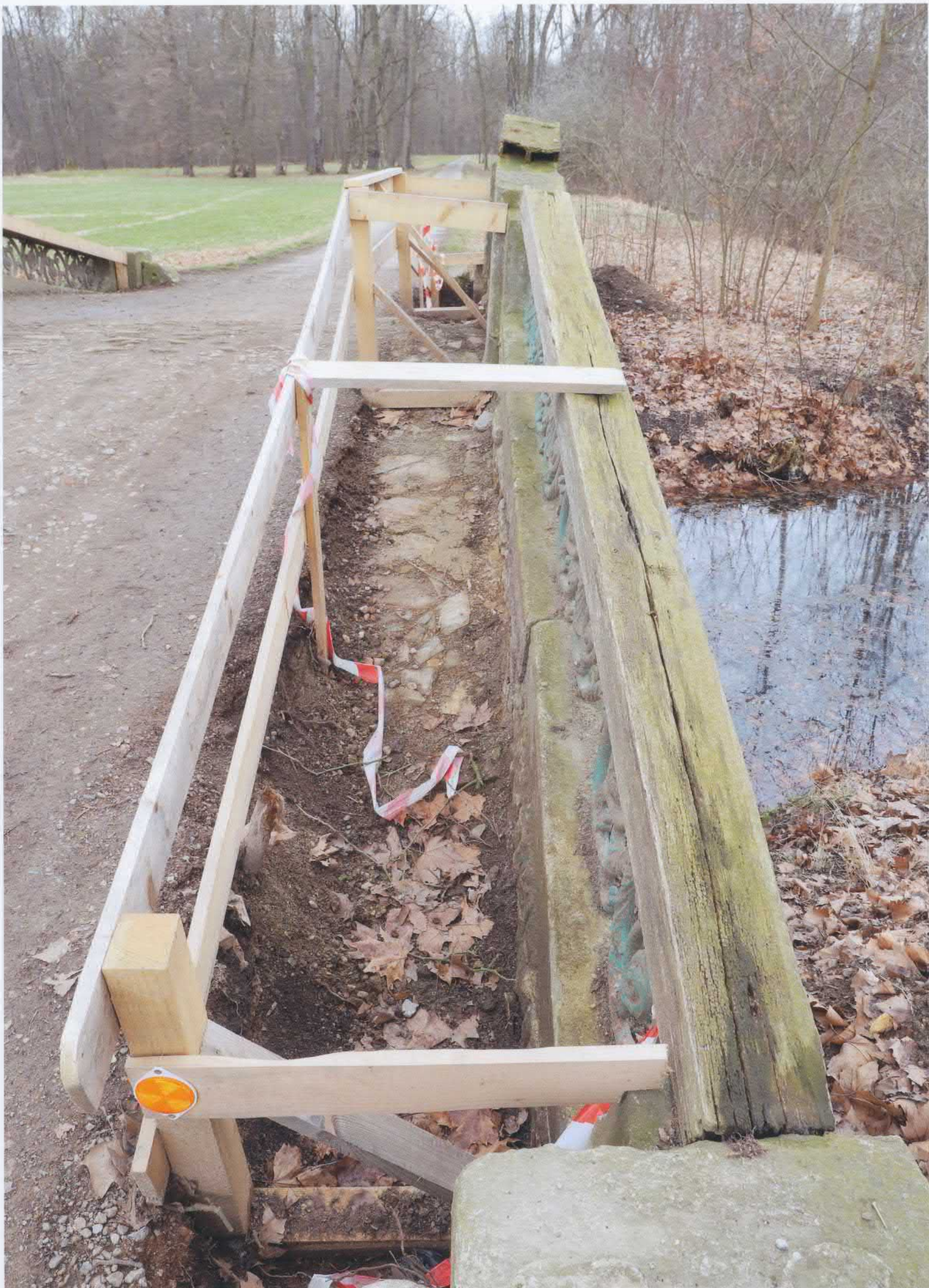
12. Státní zámek Kačina, Platanový mostek, severní strana, detail vyklonění zábradlí
