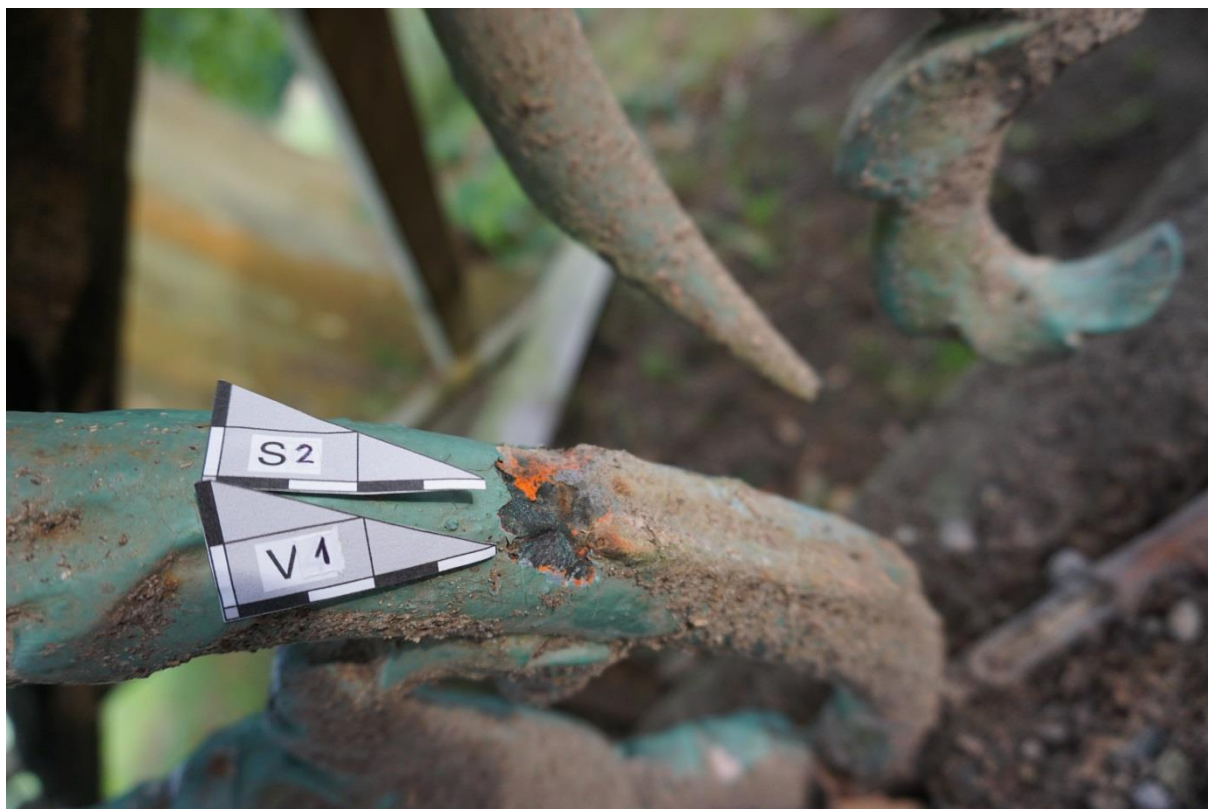
Foto č.2 – sonda S2 a odebraný vzorek (úlomek) ze spoje 1a2arabesky jižního zábradlí
