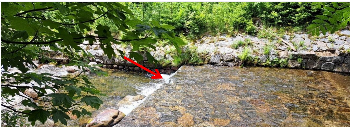
Obr. 46 Oprava spádového stupně SO 20
