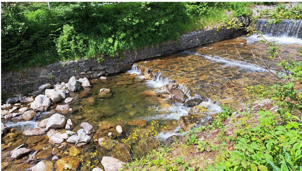
Obr. 37 Oprava výmolu ve spadišti SO 12
