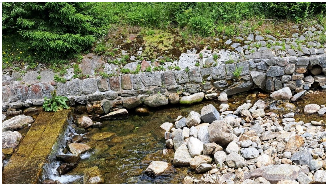
Obr. 31 Oprava kamenné dlažby SO 08
