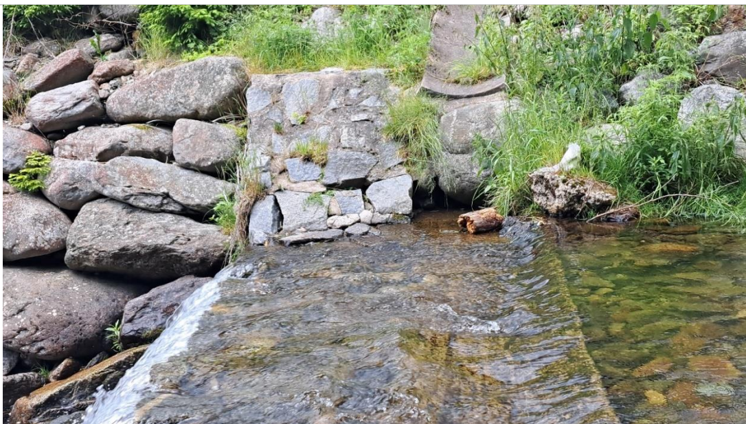
Obr. 22 Poškozené zavázání spádového stupně SO 01
