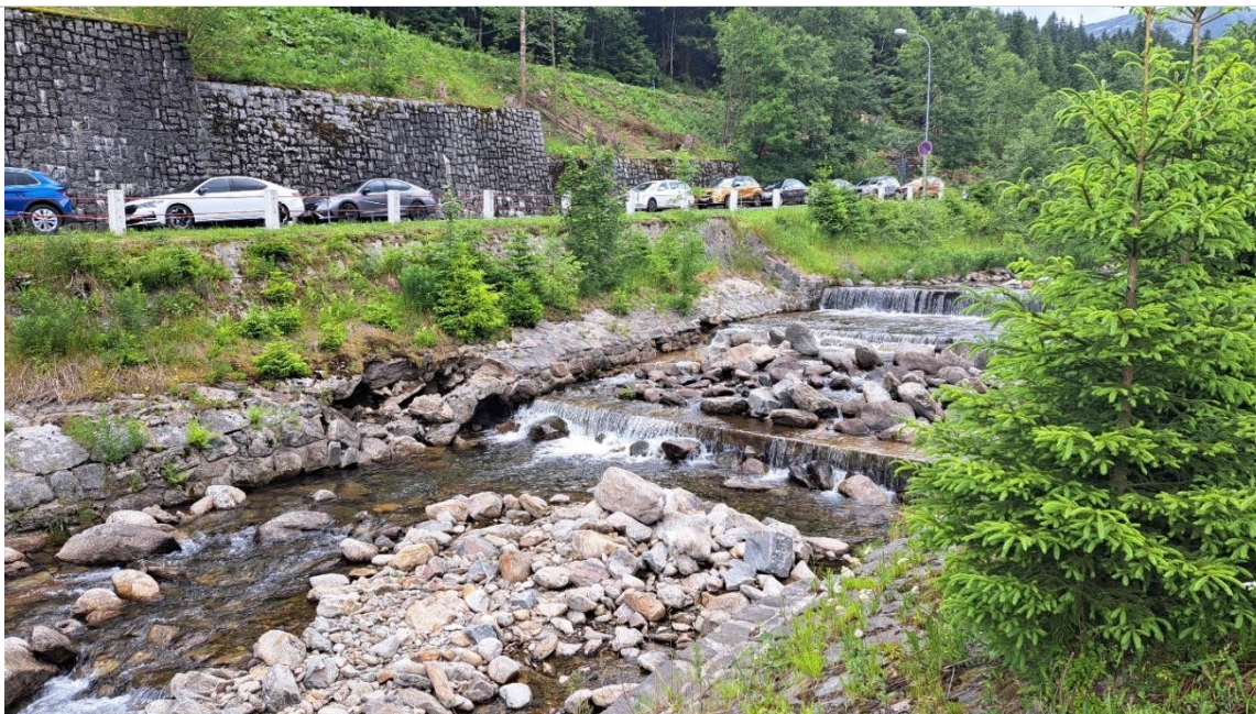
Obr. 32 Oprava kamenné dlažby SO 09
