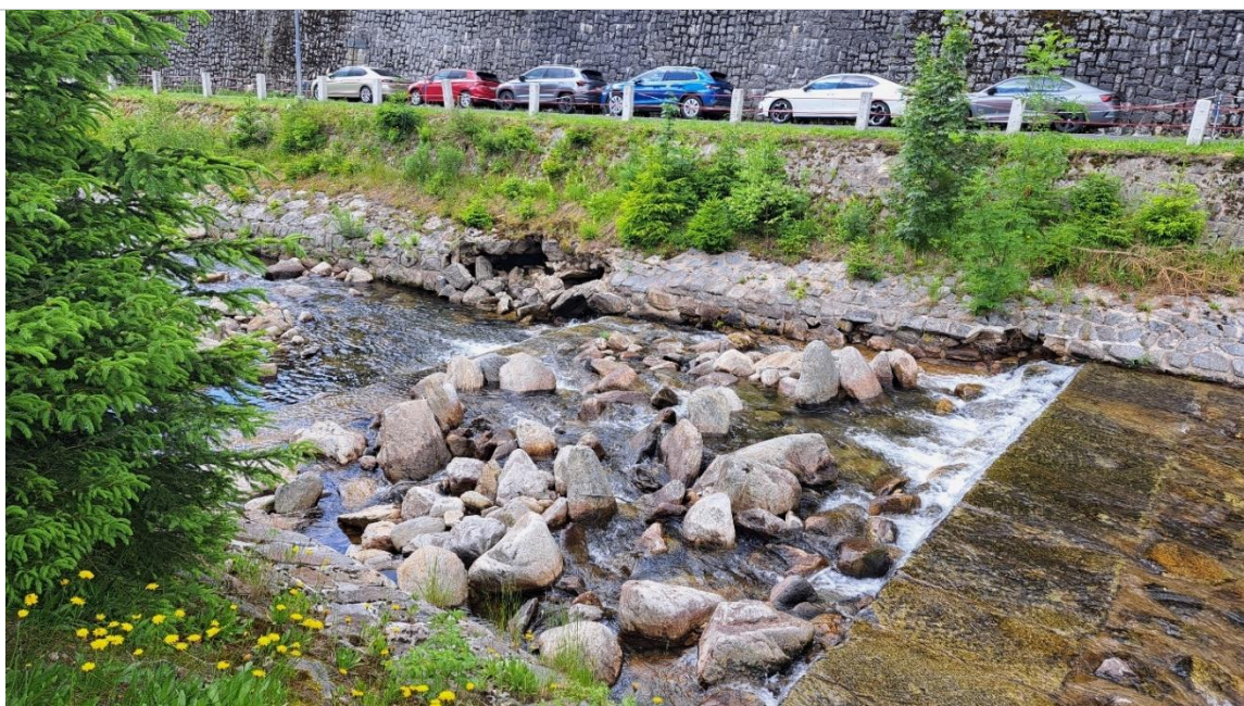
Obr. 34 Oprava kamenné dlažby SO 09
