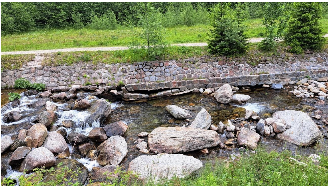
Obr. 28 Oprava kamenné dlažby SO 06
