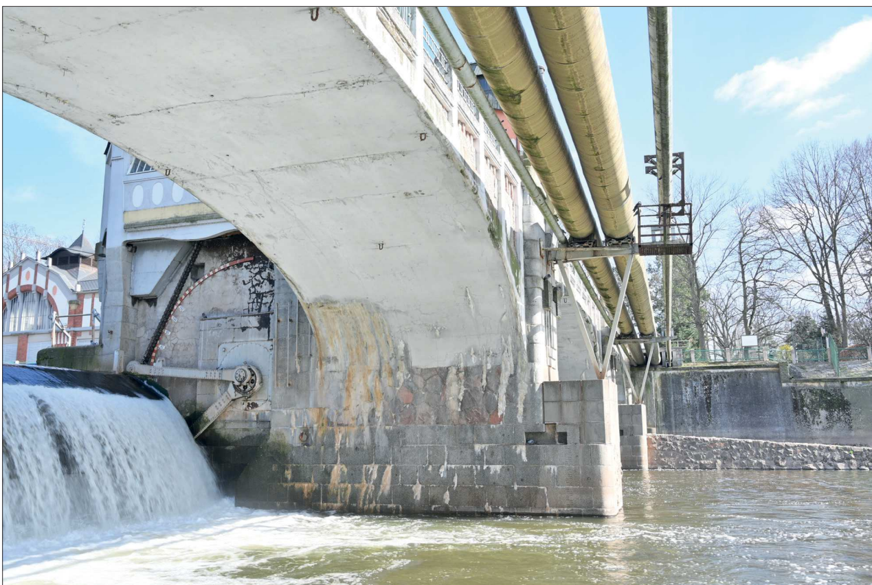
148. Pohled na výklenek v SV stěně při S nároží
