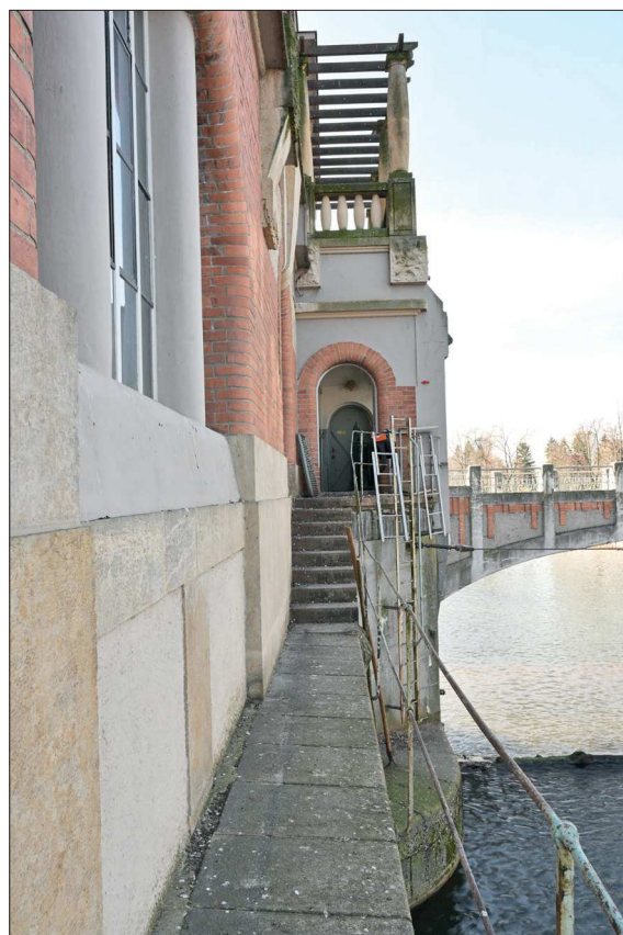
178. Pohled na výklenek v SV stěně při S nároží
