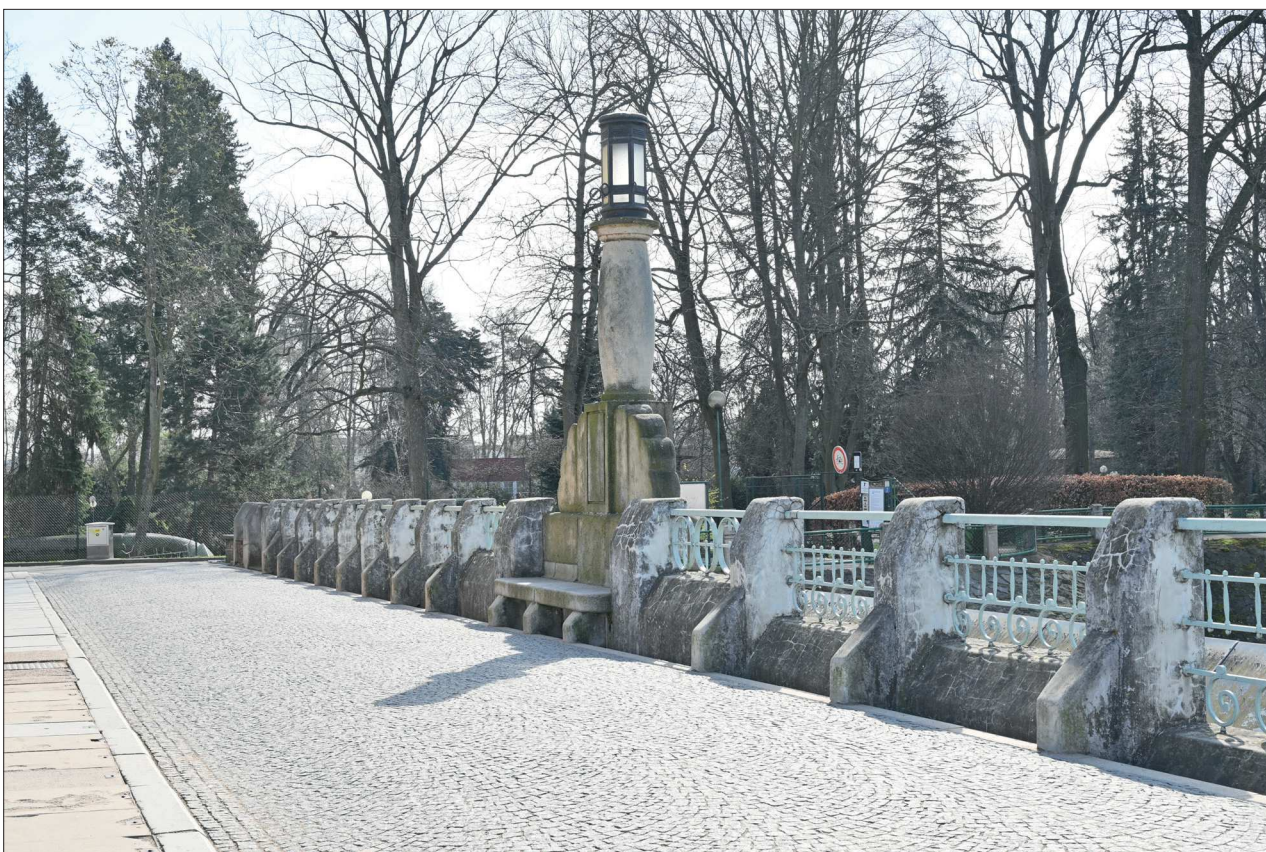
150. Pohled na výklenek v SV stěně při S nároží
