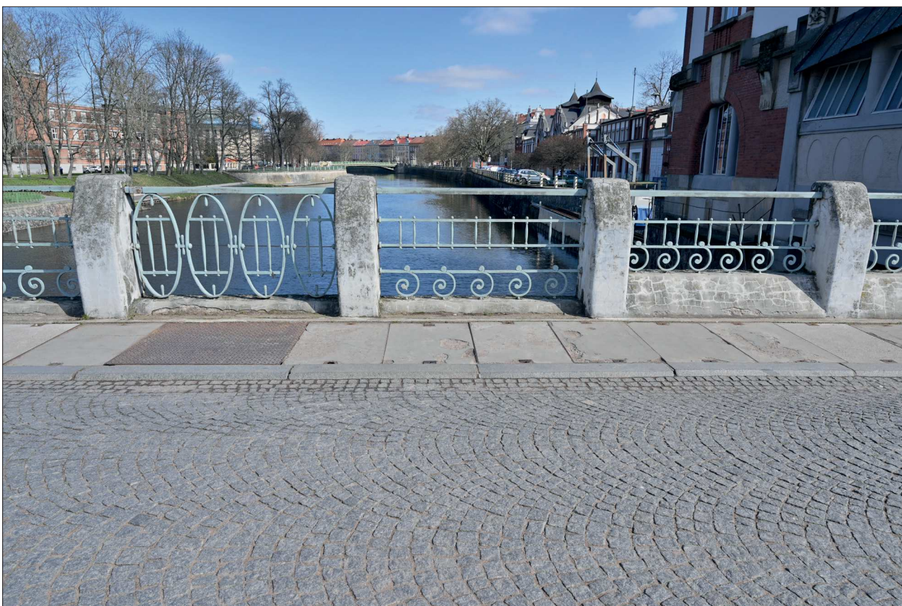
158. Pohled na výklenek v SV stěně při S nároží
