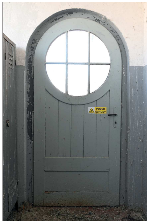
134. Pohled na zdivo JZ stěny u Z nároží v patře
