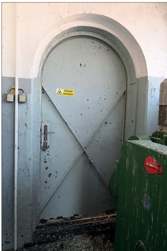
133. Pohled na zdivo JZ stěny nad vchodem v patře
