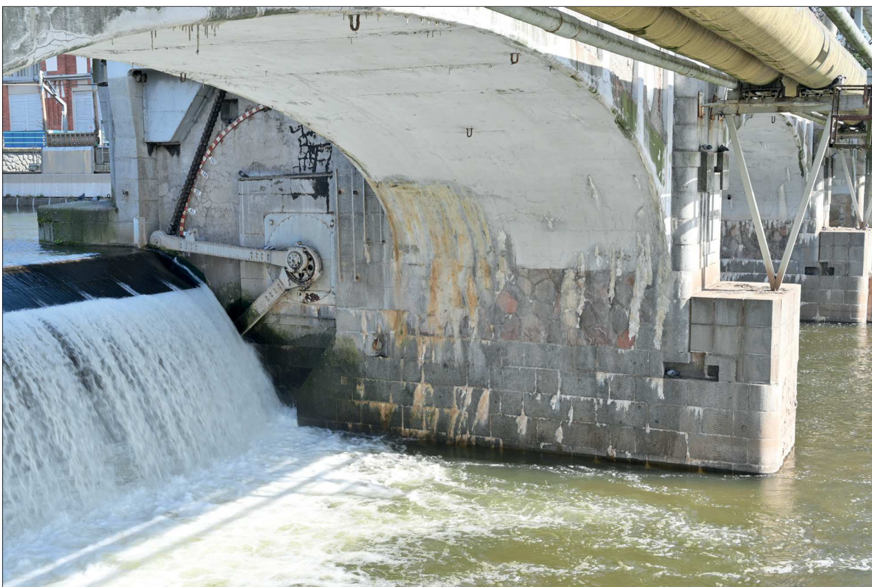
168. Pohled na výklenek v SV stěně při S nároží
