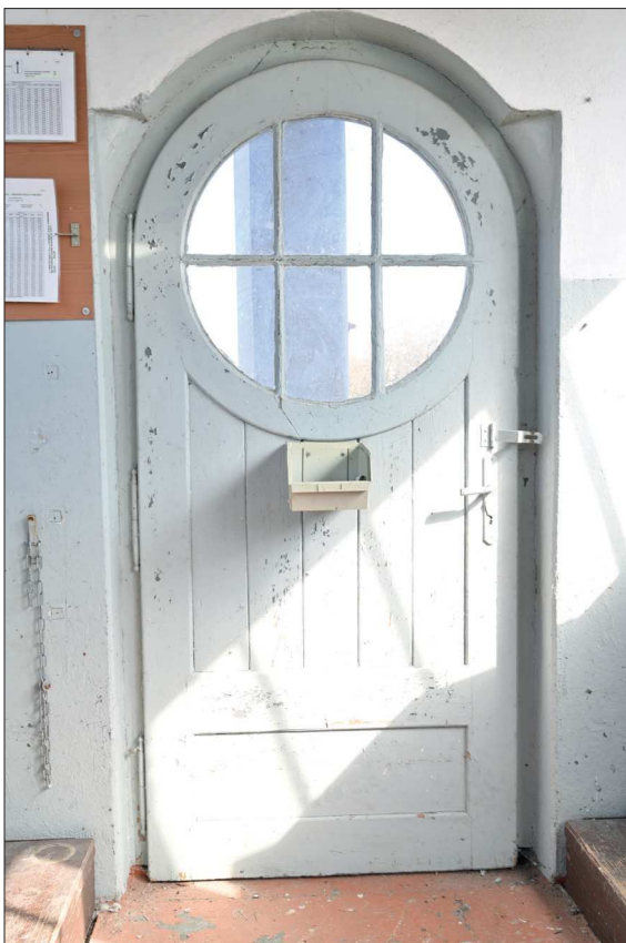
125. Pohled do nárožní místnosti při SZ stěně v přízemí
