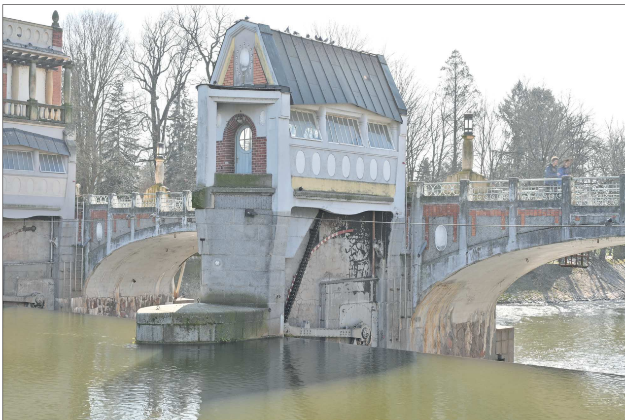
107. Pohled na zastřešení Sz části objektu od SV
