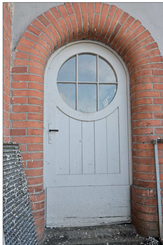
136. Pohled na zdivo JZ stěny u Z nároží v patře
