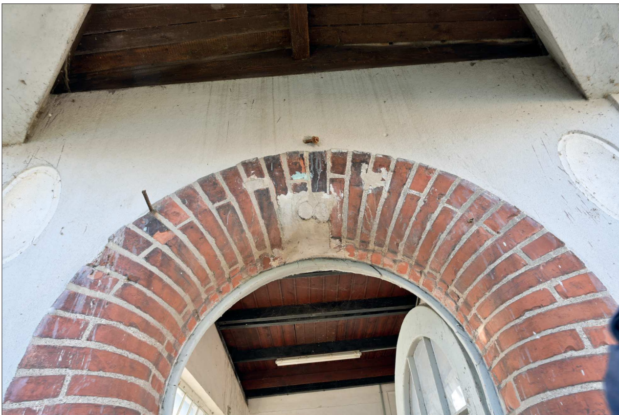
114. Pohled na zdivo JZ stěny u Z nároží v patře
