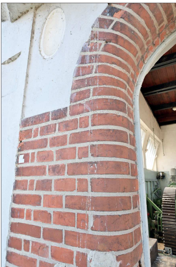
115. Pohled na zdivo JZ stěny nad vchodem v patře
