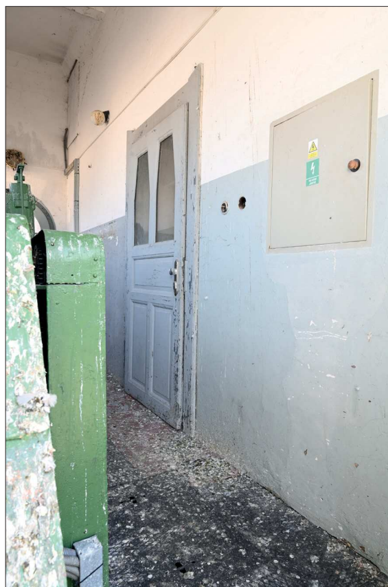
132. Pohled na zdivo JZ stěny u Z nároží v patře
