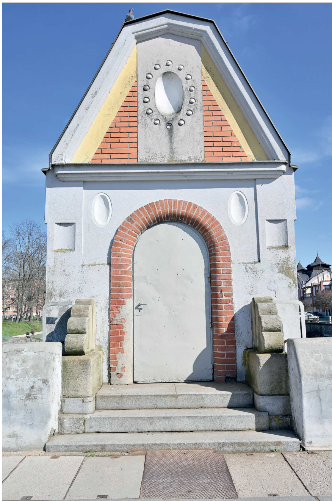
108. Pohled na vazbu střešní roviny na zvýšenou korunu nad SZ průčelím, pohled od východu
