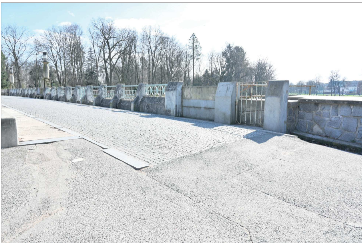
154. Pohled na výklenek v SV stěně při S nároží
