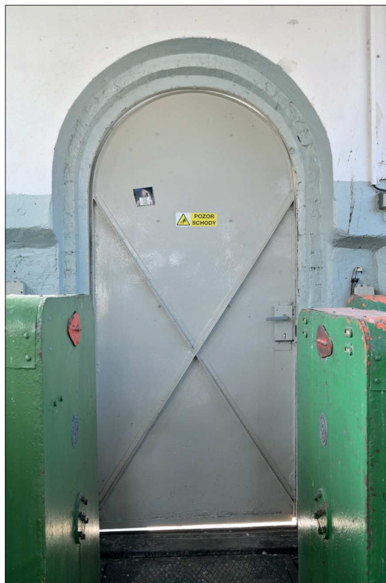
126. Pohled na korunu zdiva SZ stěny nad vloženým patrem od JV
