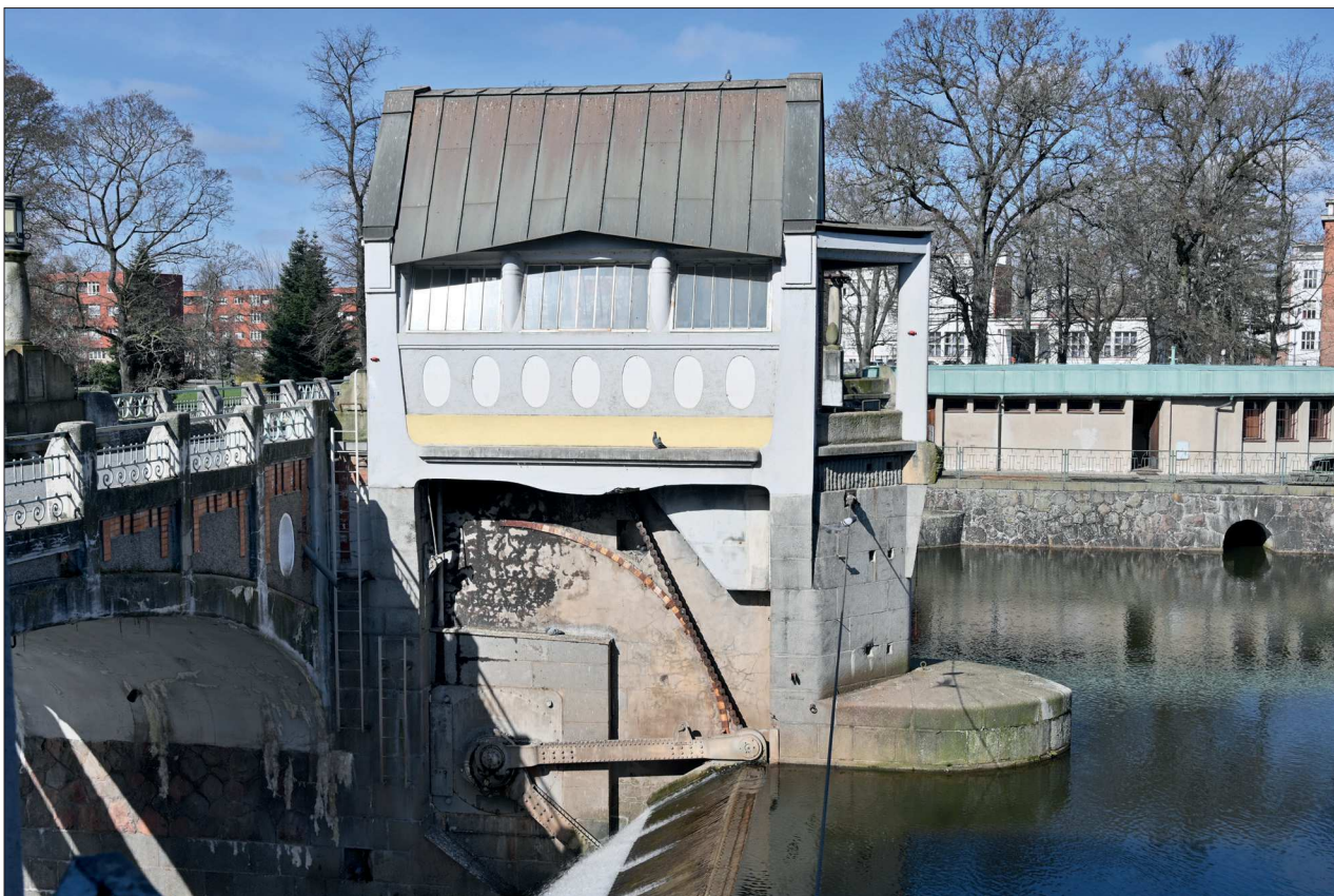
104. Celkový pohled na zastřešení objektu od východu
