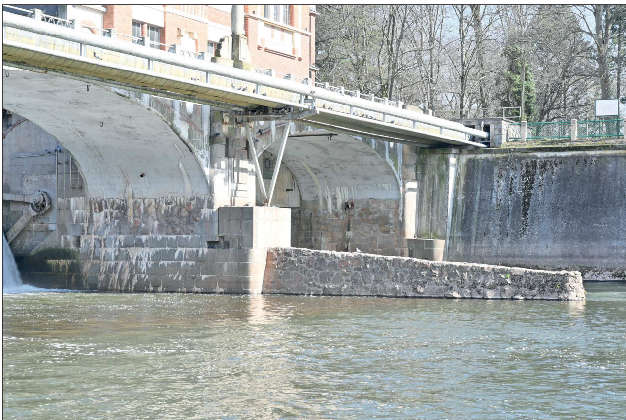
174. Pohled na výklenek v SV stěně při S nároží
