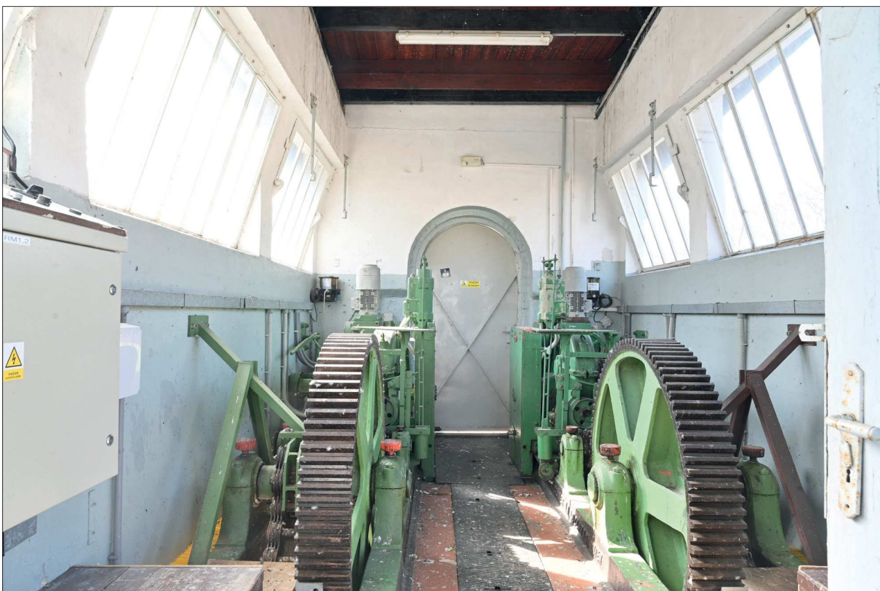
119. Celkový pohled na JZ stěnu od východu
