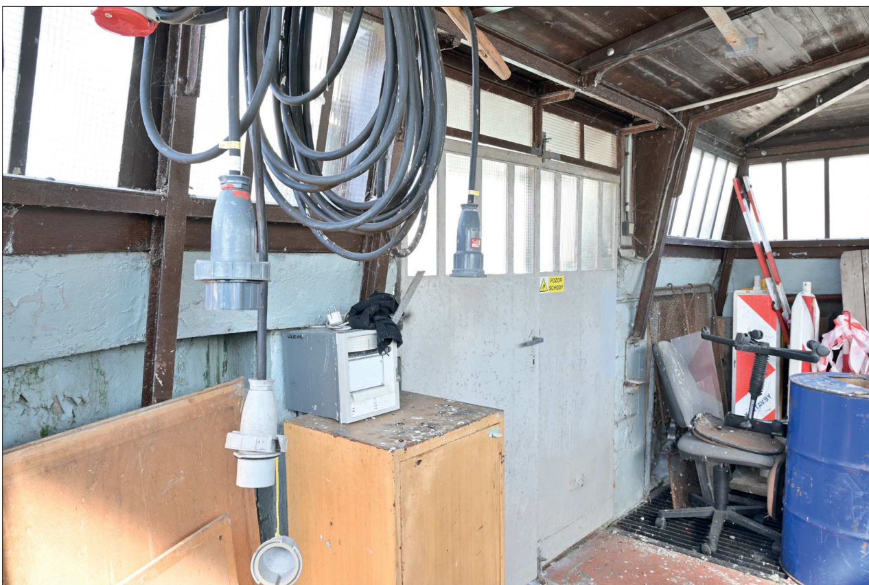
99. Pohled na horní úroveň JZ části JV průčelí
