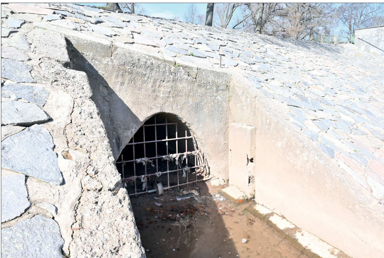
192. Pohled na výklenek v SV stěně při S nároží
