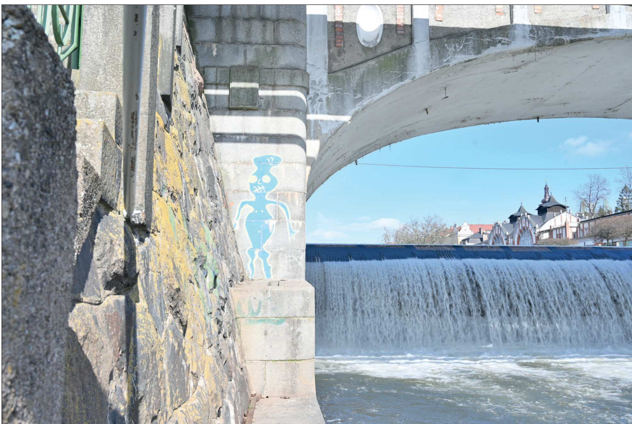
166. Pohled na výklenek v SV stěně při S nároží
