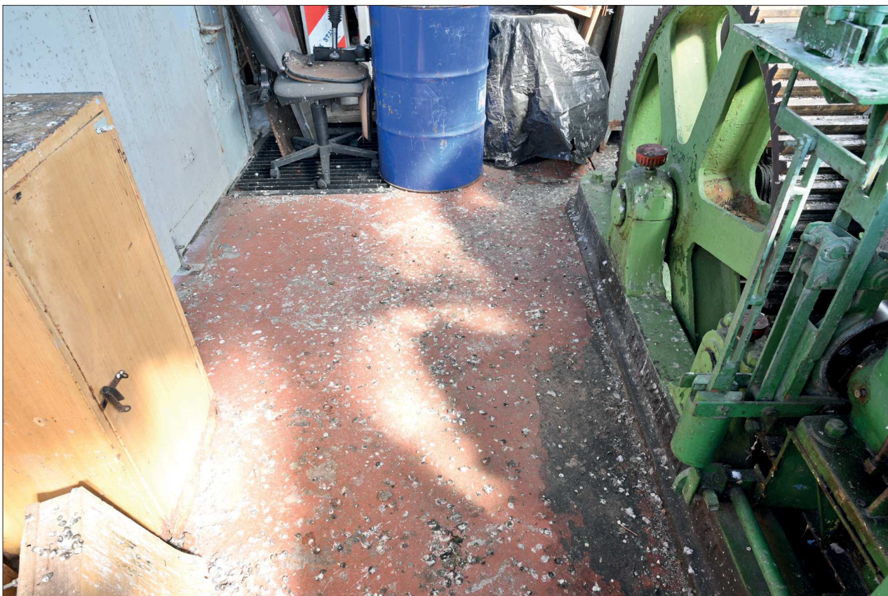
102. Celkový pohled na navazující tarasní zeď na SV straně dvorka u čp. 10, horní úroveň
