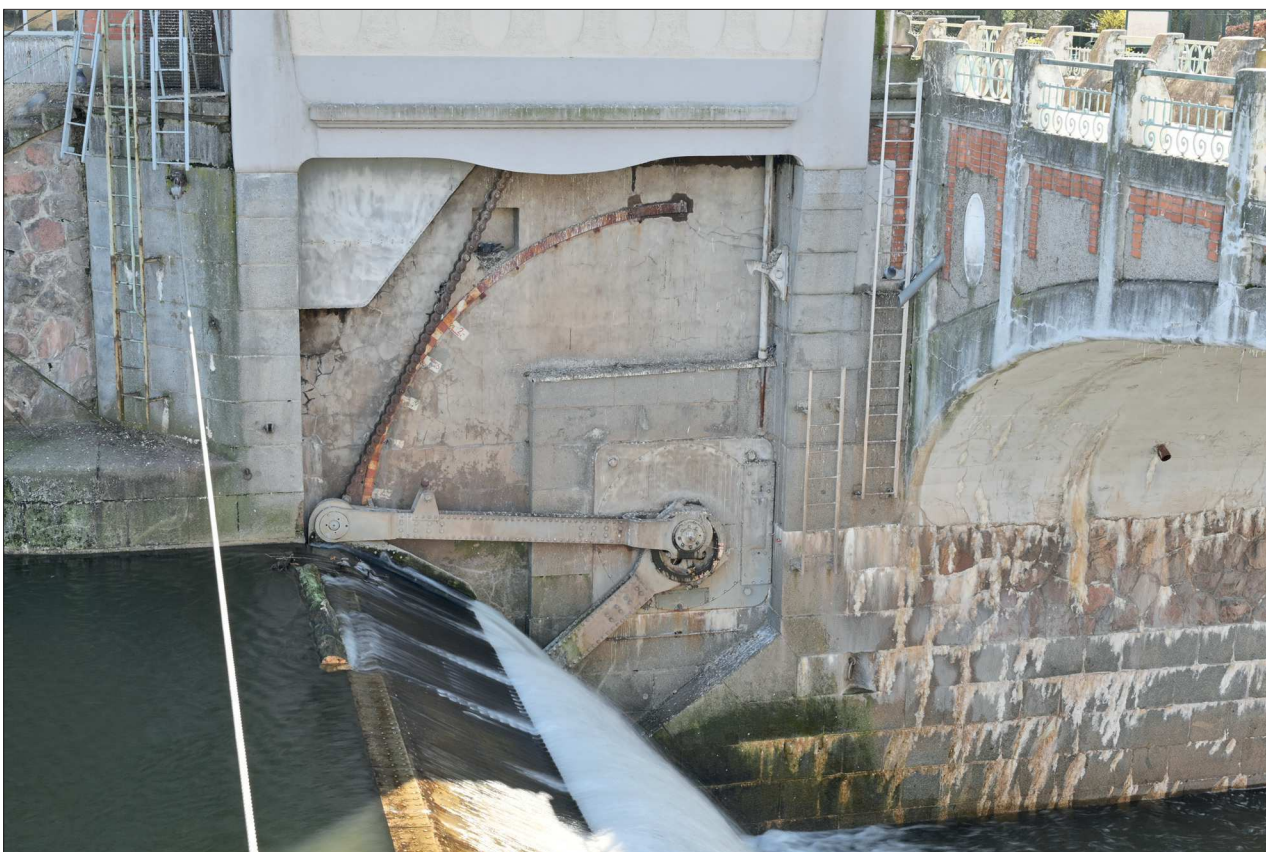
172. Pohled na výklenek v SV stěně při S nároží
