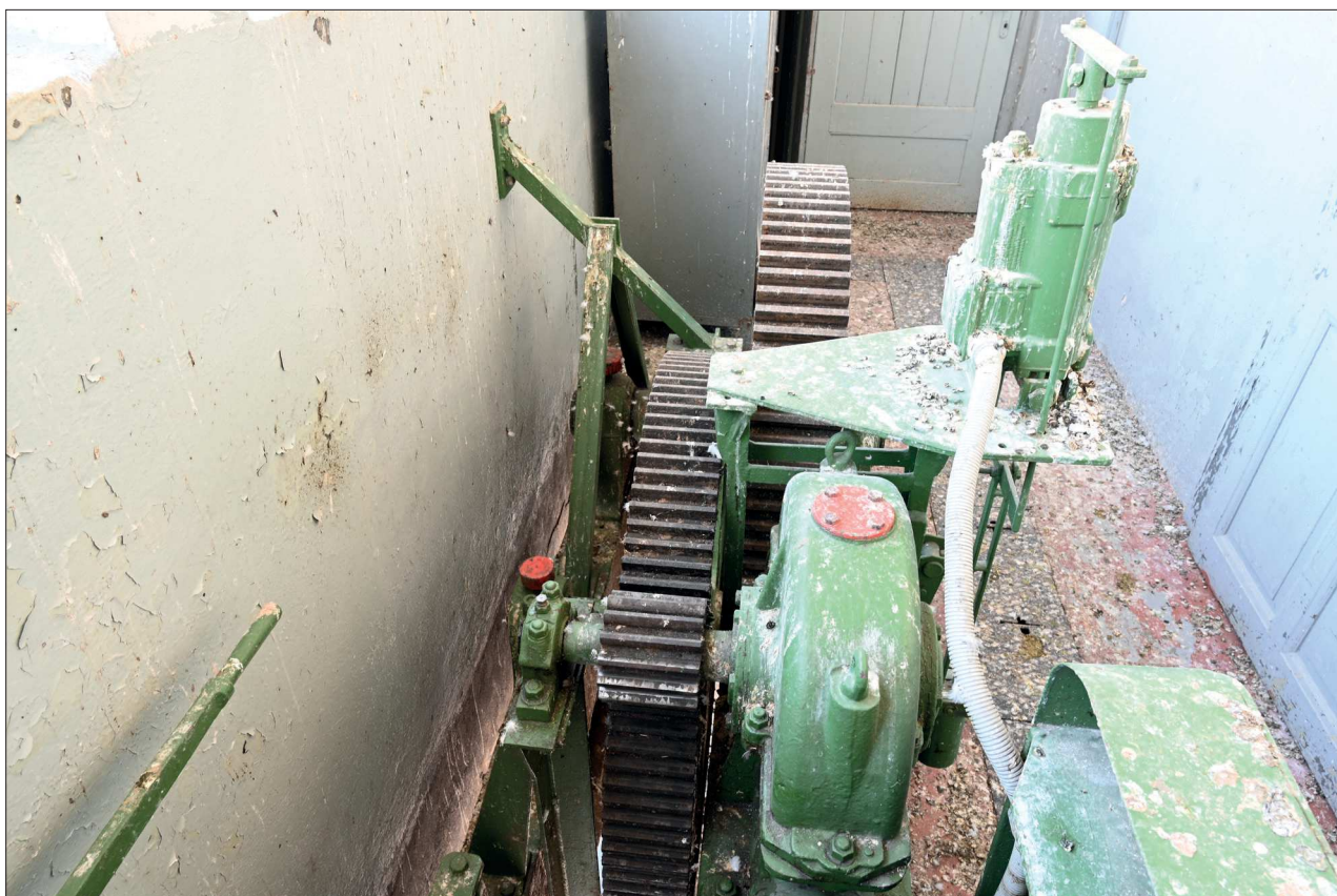
140. Pohled na výklenek v SV stěně při S nároží
