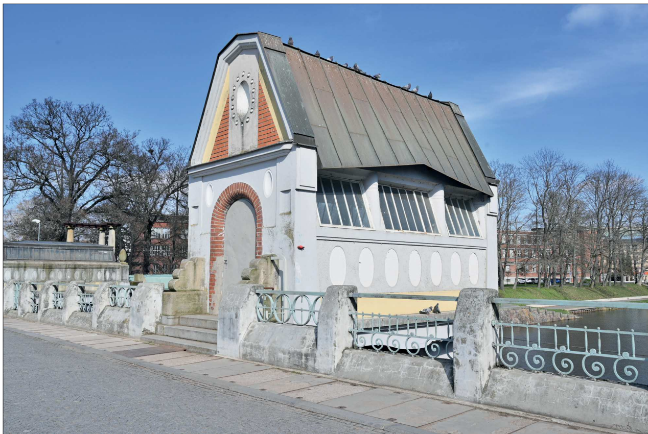
106. Celkový pohled na zastřešení objektu od východu
