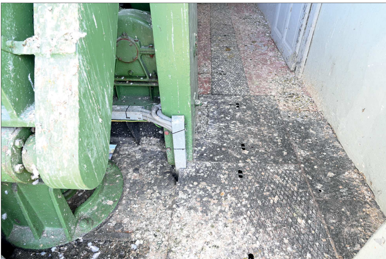
142. Pohled na výklenek v SV stěně při S nároží
