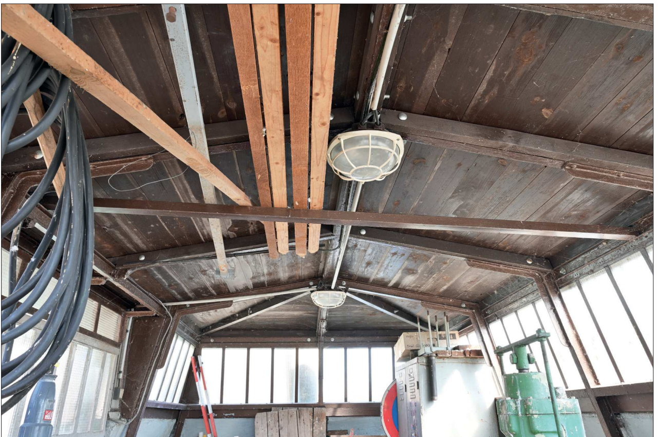
97. Pohled na spodní úroveň SV části JV průčelí
