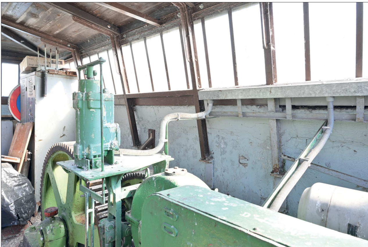
98. Pohled na horní úroveň střední části JV průčelí
