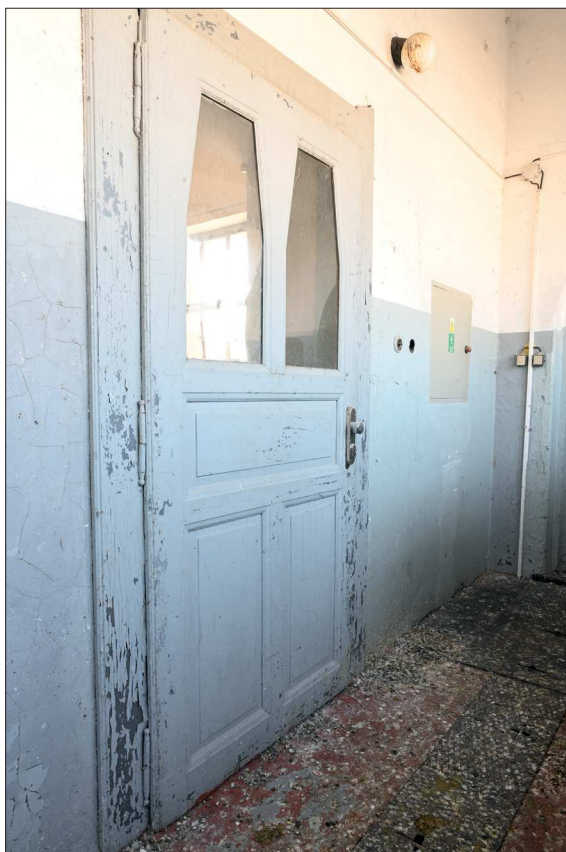
135. Pohled na zdivo JZ stěny nad vchodem v patře
