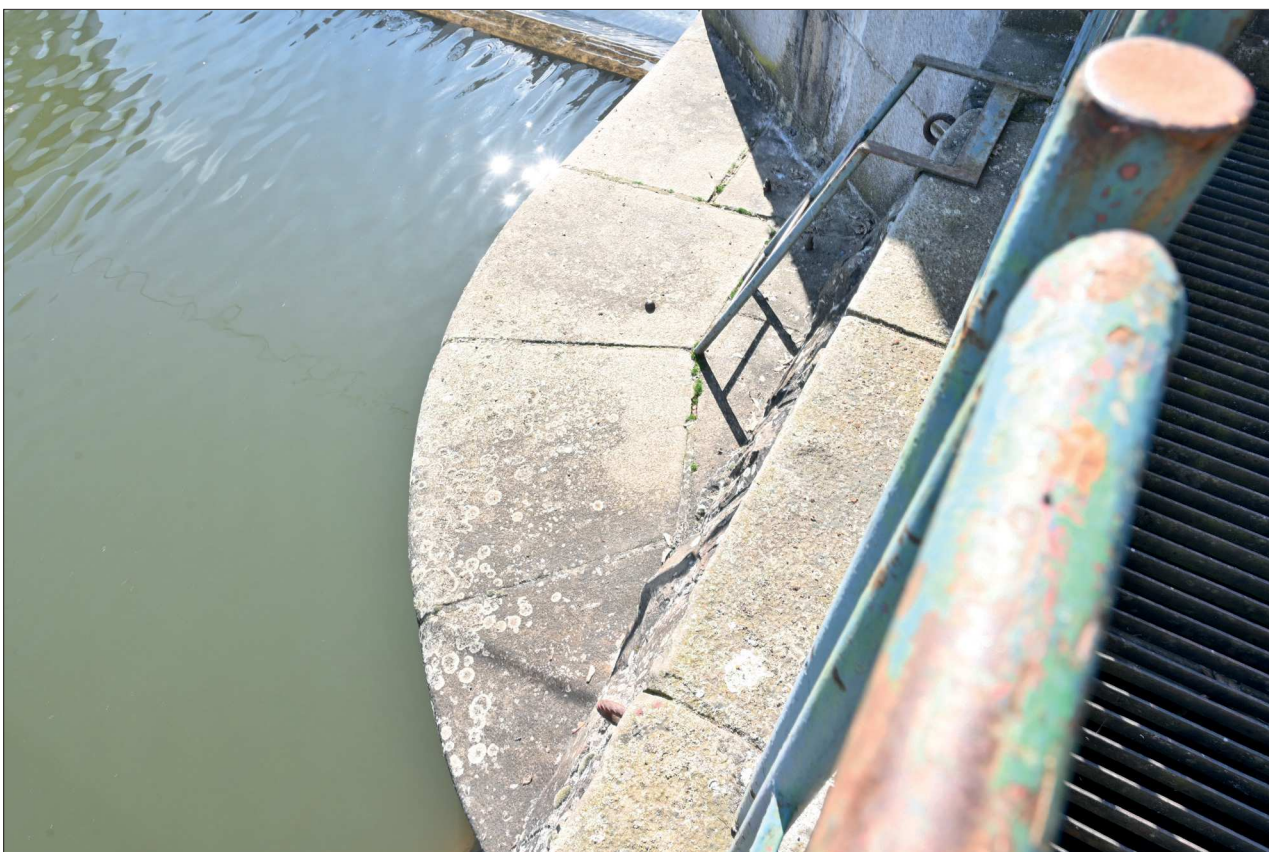
164. Pohled na výklenek v SV stěně při S nároží
