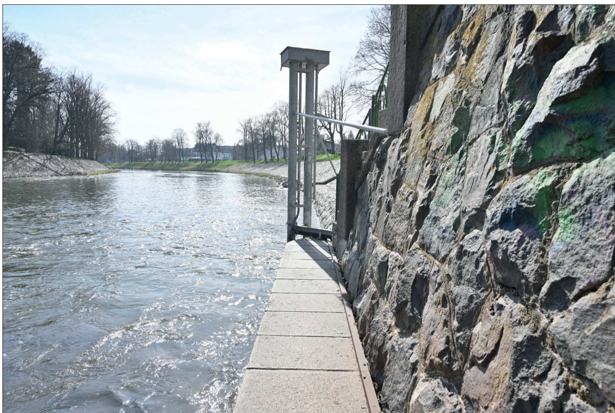
194. Pohled na výklenek v SV stěně při S nároží
