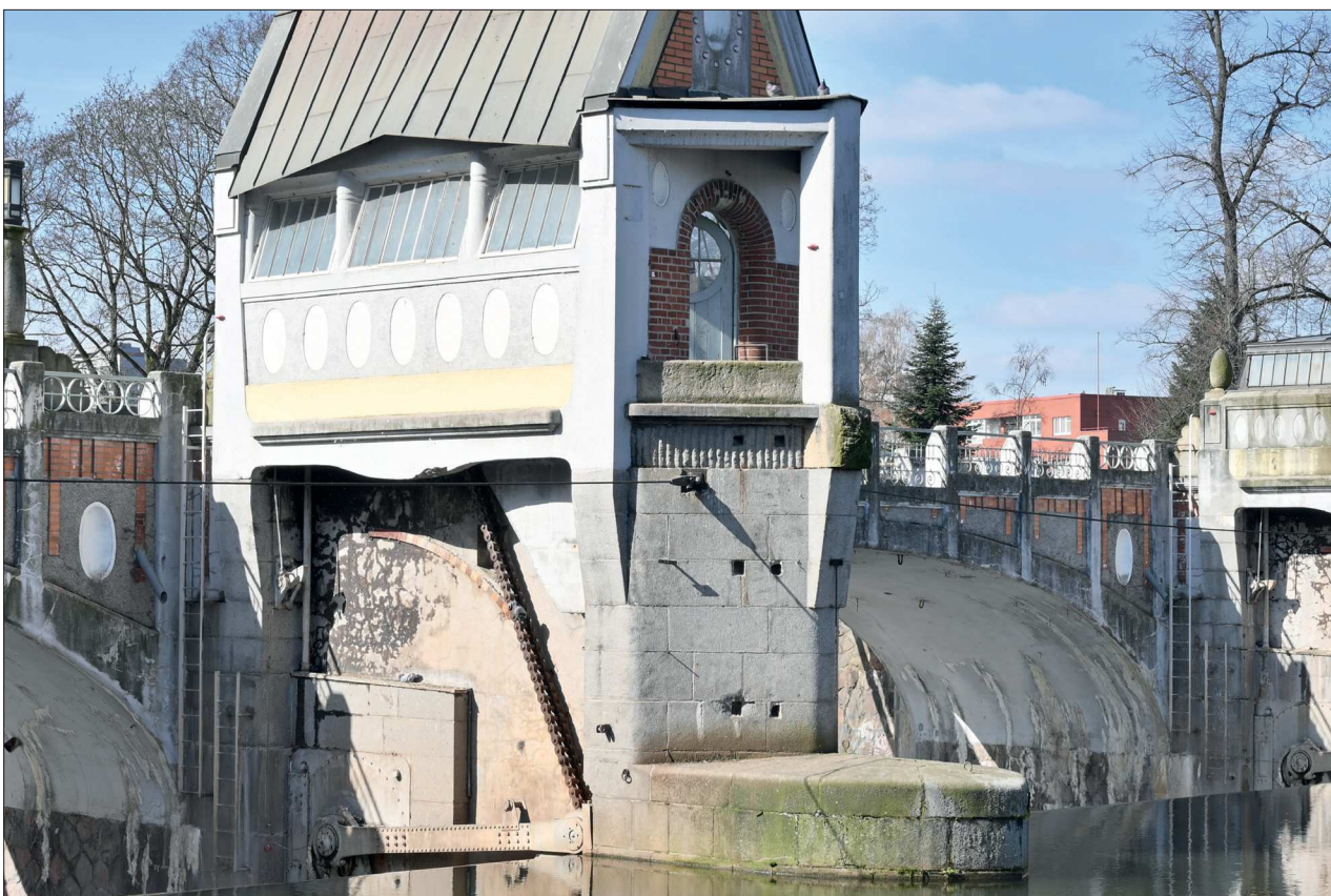
105. Pohled na zastřešení JV části objektu od SV
