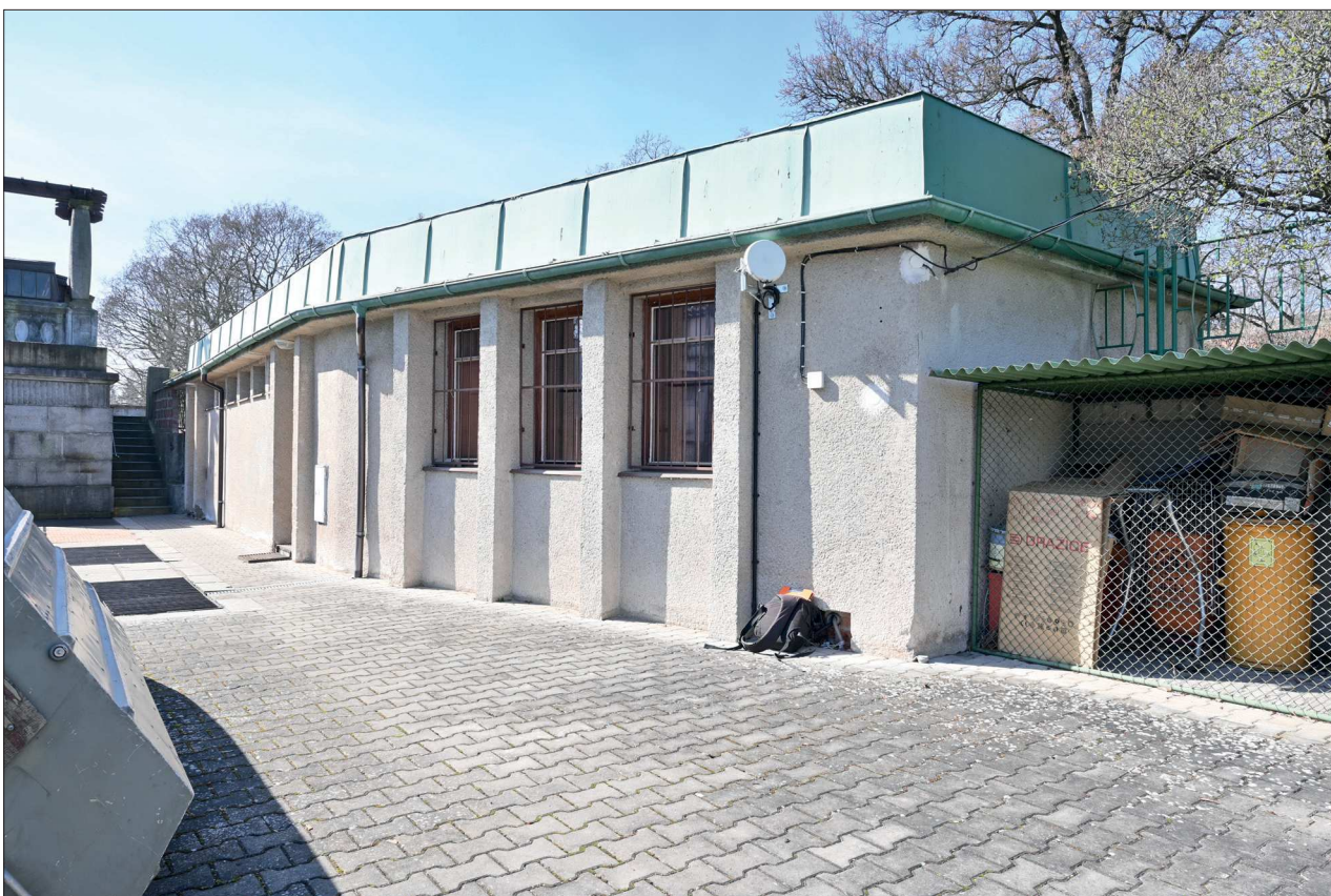
186. Pohled na výklenek v SV stěně při S nároží
