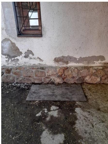
Vstupní poklop do žumpy u štitové stěny
