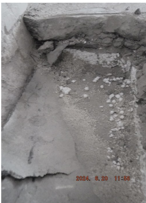
Sonda č.2 - 1np podlahová konstrukce
