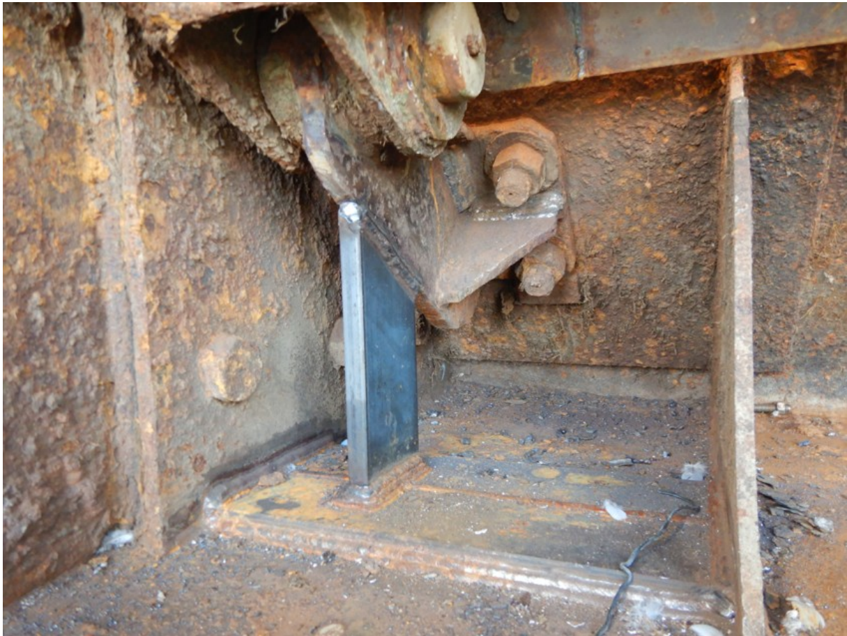
Oprava pravého ložiska levé jezové klapky r.2023 (obdobně opravit i levé ložisko)
