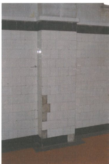
FOTO č. 13: MVE I chybějící obklad
