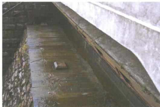
FOTO č. 17: MVE II stávající opláštění kaskády dř. obkladem v horní části klapky
