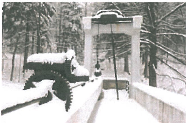
Obr. 15. Liberec-Rudolfov, automatický klapkový uzávěr s protizdvíhačem na brázi vyrovnávací nádrže, v pozadí zídka s pavilónem kamenem stavby. (Foto: Petr Freiwilling, 2013)
