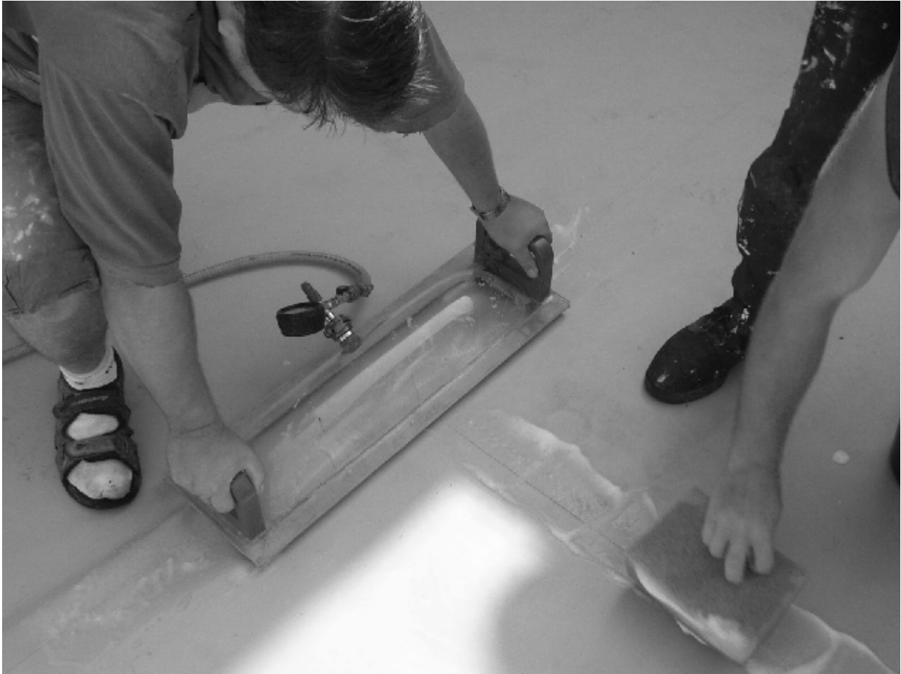
Obrázek 21.: Zkoušení těsnosti spojů vakuovou zkouškou
