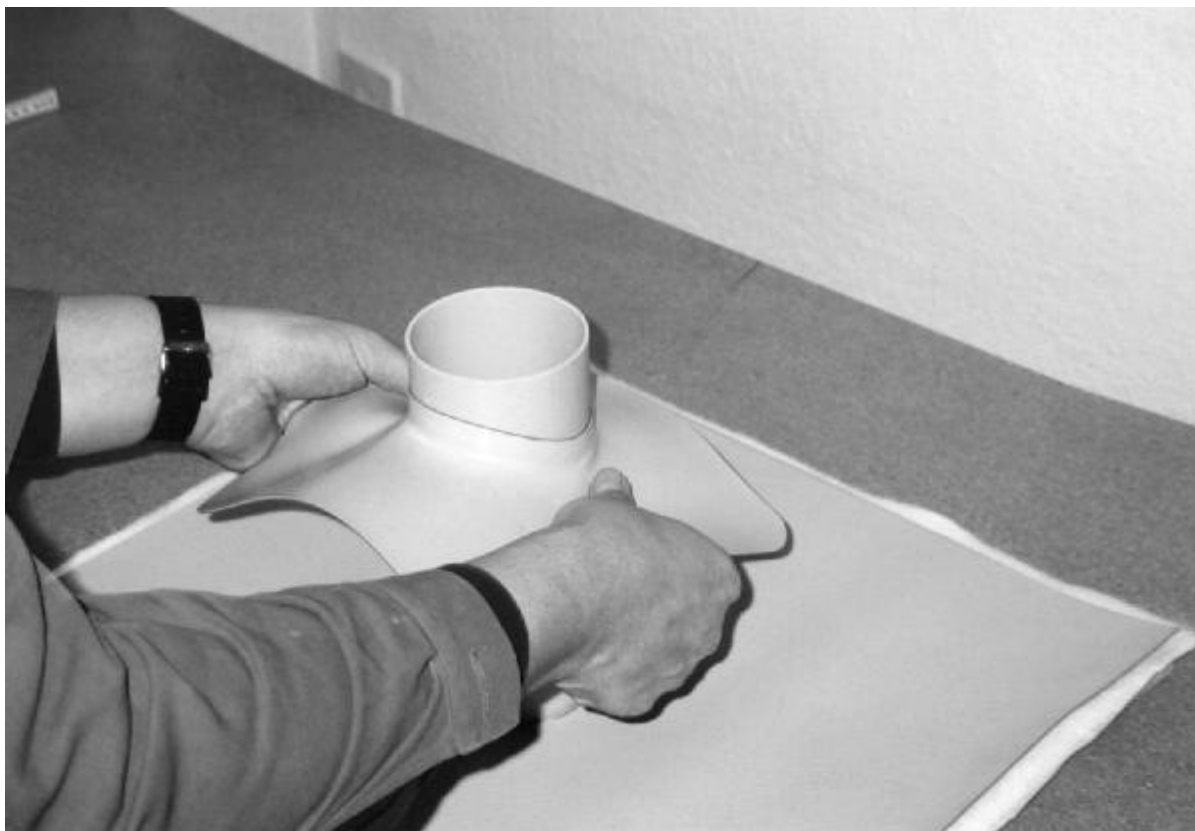
Obrázek 16.: Opracování prostupu - nasazení manžety na prostup
