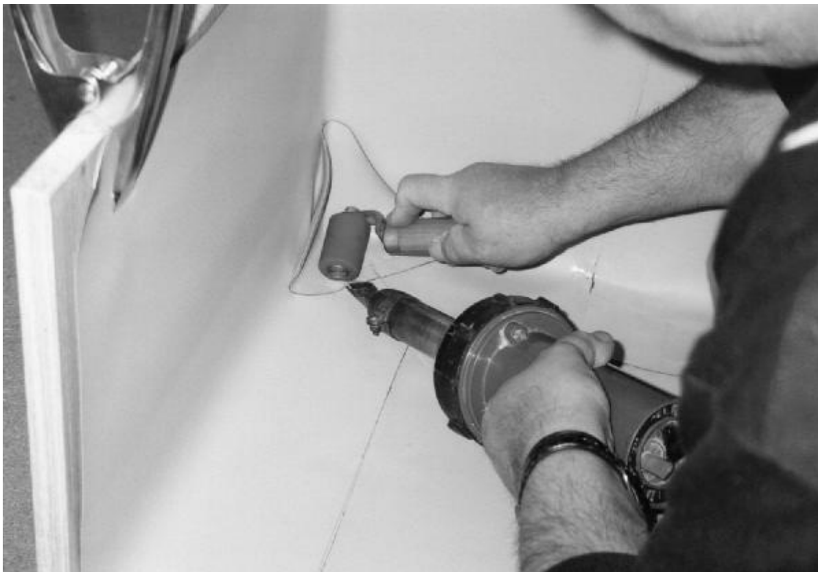
Obrázek 11.: Postup opravování hydroizolace v koutu - navaření koutové tvarovky
